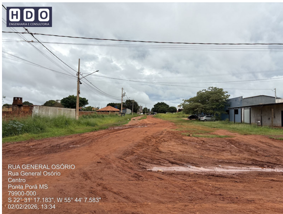
Imagem 06: Rua General Osório
