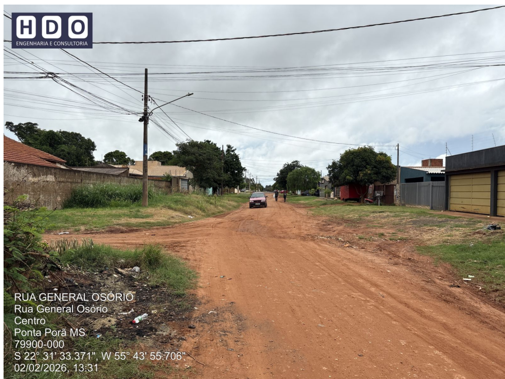
Imagem 05: Rua General Osório
