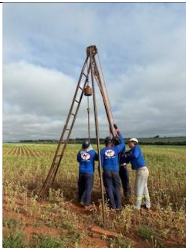
Figura 18 – Sondagem SPT P04.
