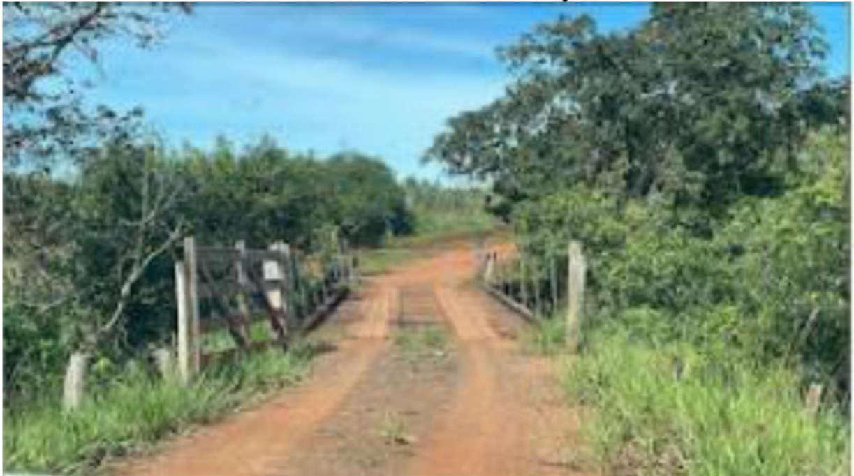
PONTE RIO ANHANDUIZINHO
