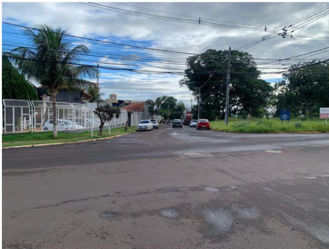
Figura 12: Fotografia do local / Fonte: PMCG
