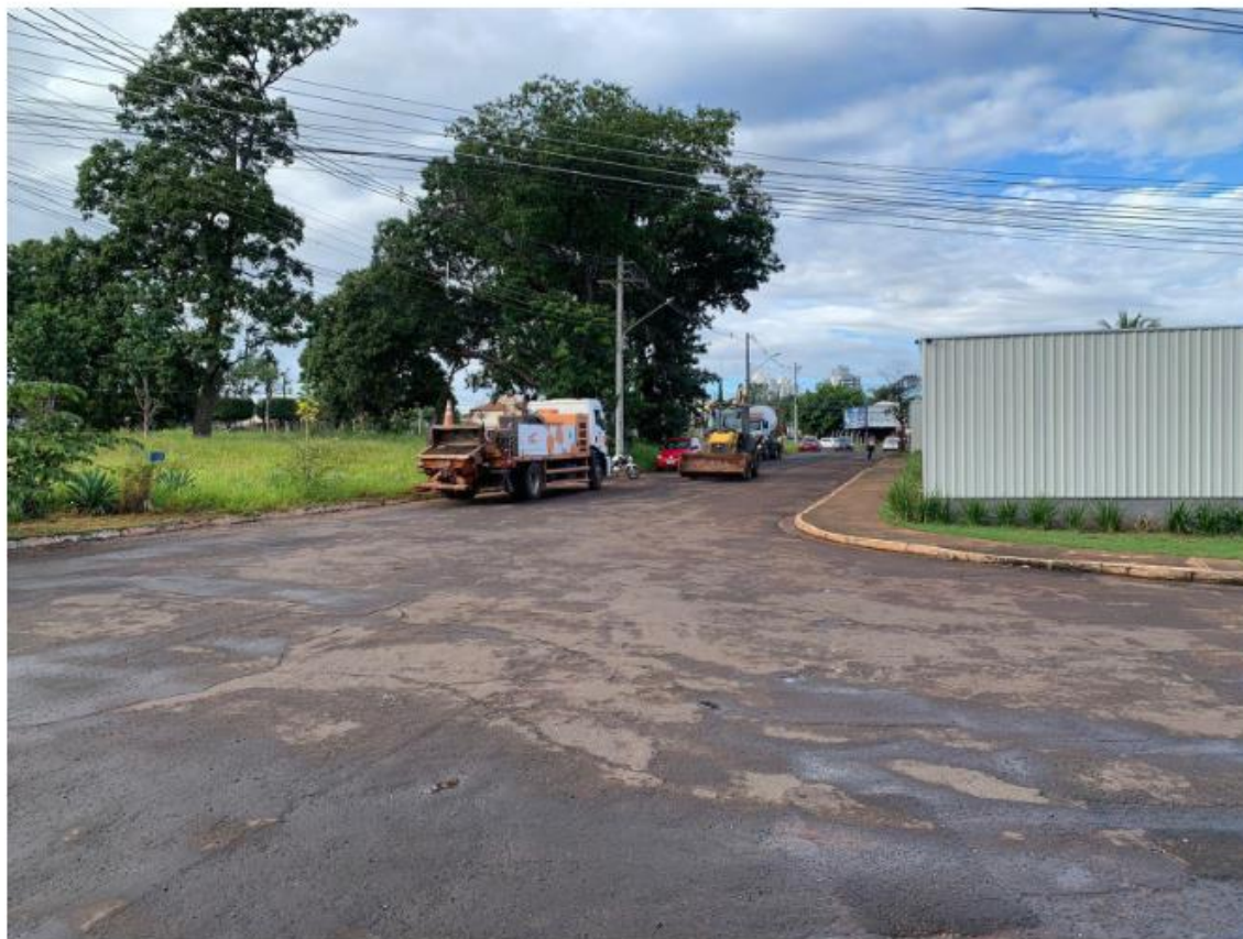
Figura 17: Fotografia do local / Fonte: PMCG
