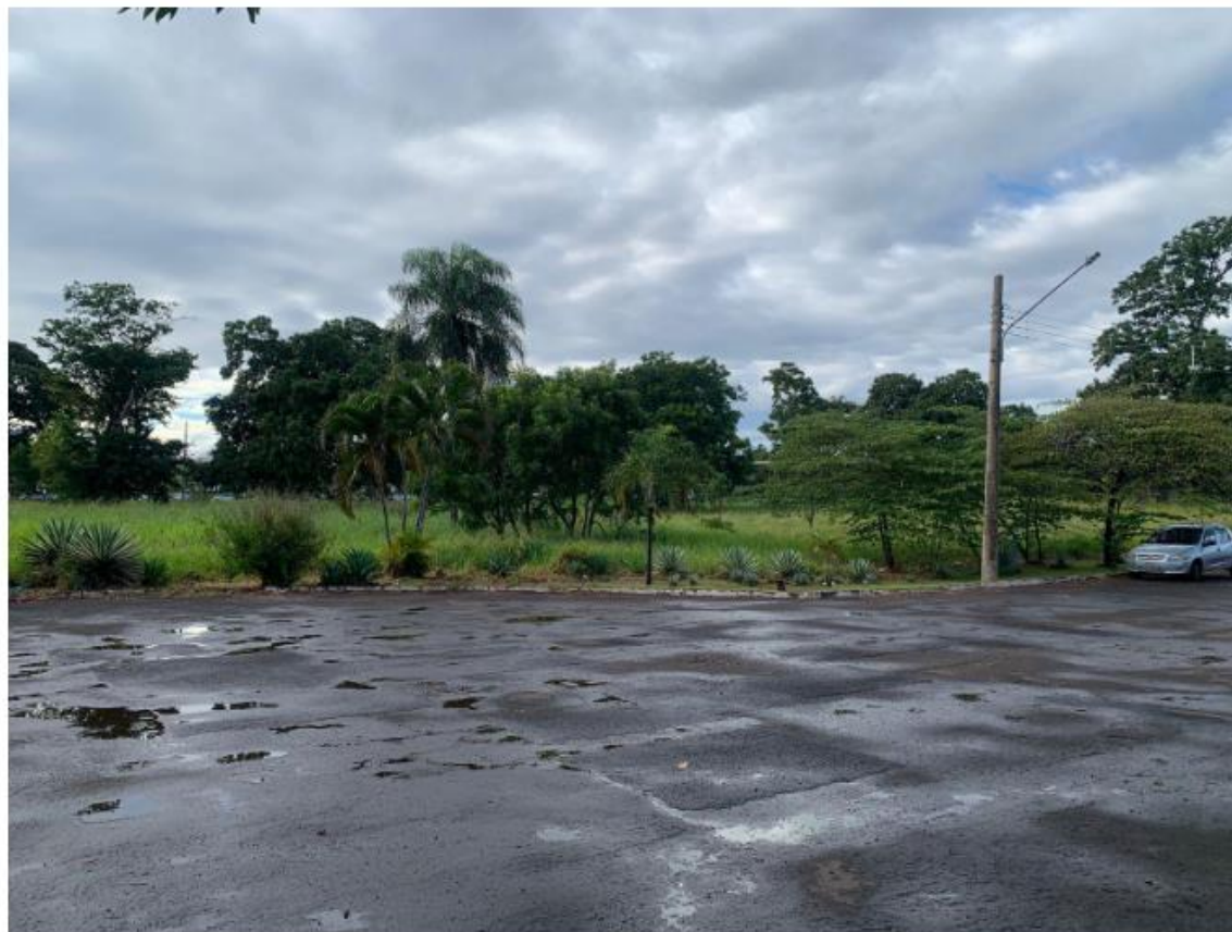
Figura 13: Fotografia do local / Fonte: PMCG
