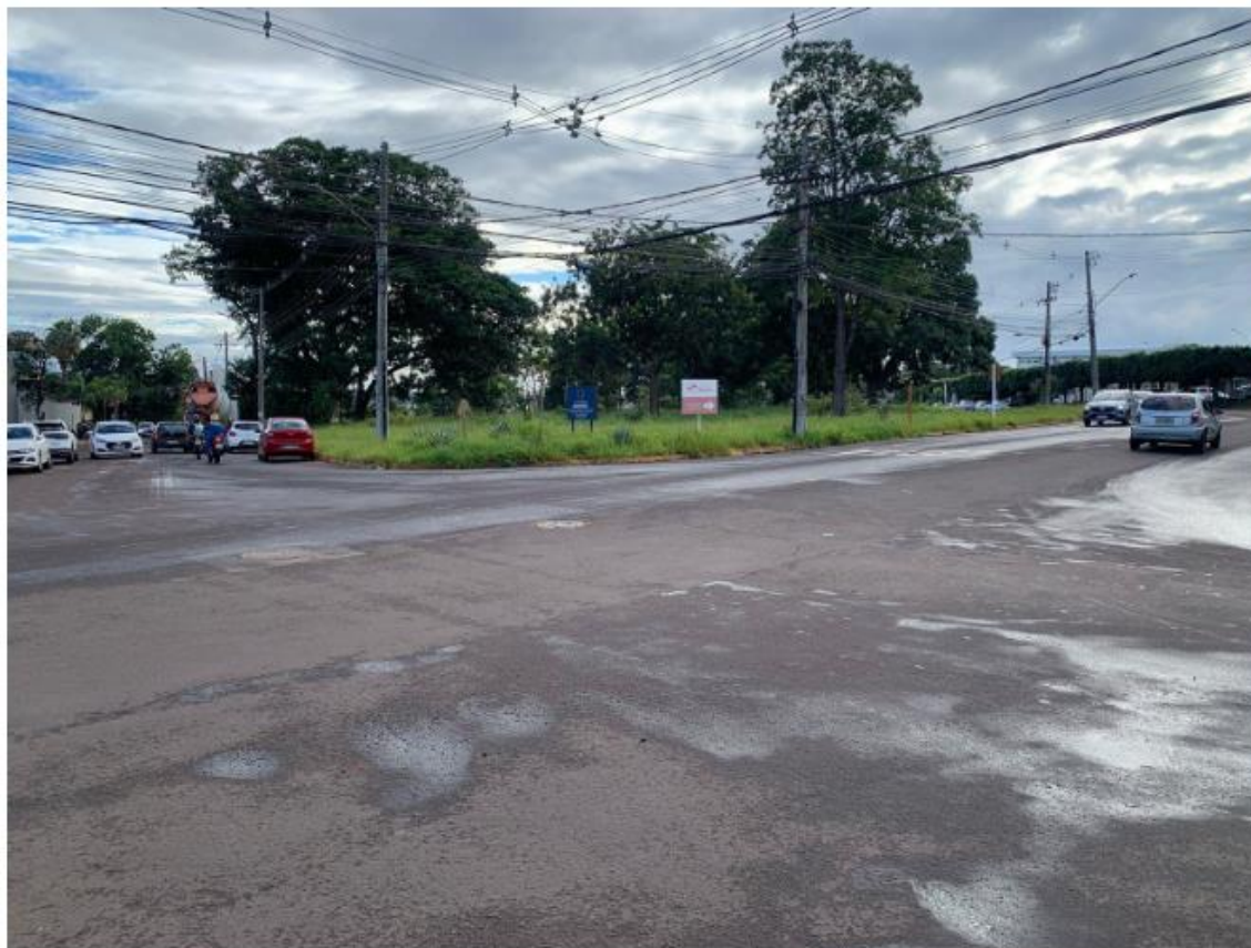
Figura 11: Fotografia do local / Fonte: PMCG
