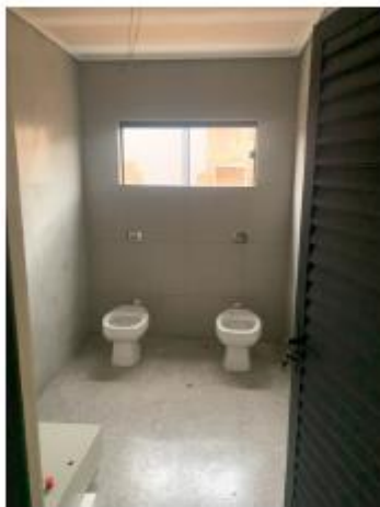
Figura 4 - Banheiro / Fonte: CIF
