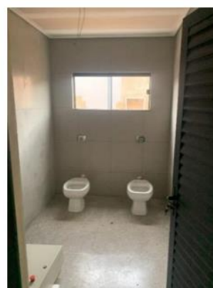
Figura 6 – Foto do banheiro do térreo. Fonte: CIF.
