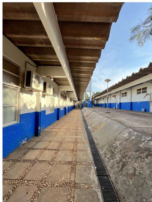
CIRCULAÇÃO EXTERNA: DEMOLIÇÃO E/OU REGULARIZAÇÃO DO CONTRA PISO EXISTENTE, TROCA DE TODA A COBERTURA.
