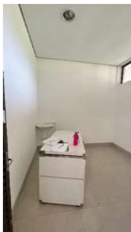
Imagem 07: Embutir tubulação de ligação de lavatório
