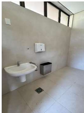
Imagem 09: substituição na acabamento ralo.
