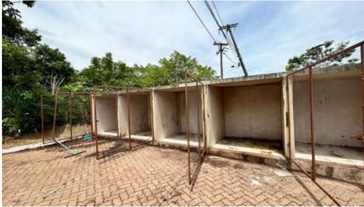
Imagem 17: Instalação de pontos de água em cada departamento.
