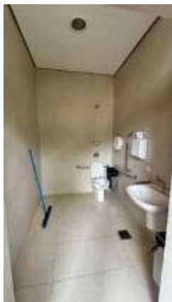
Imagem 06: Substituição acabamento ralo.
