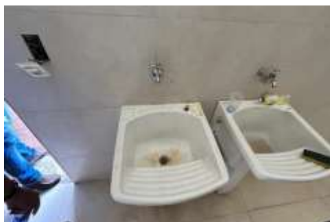
Imagem 15: Retirada dos tanques
