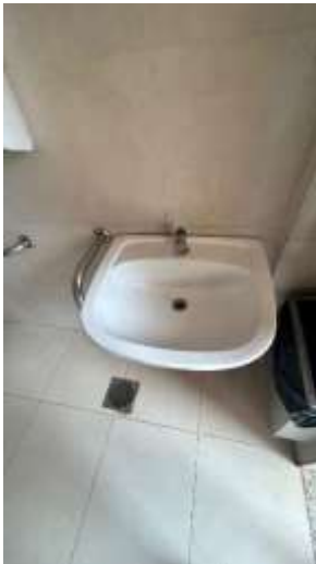
Imagem 05: Substituição torneira, acabamento ralo
