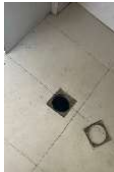
Imagem 12: Substituição acabamento ralo.
