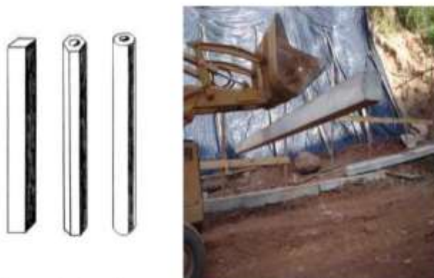
Diferentes tipos de seções e transporte de estaca no canteiro de obras.
