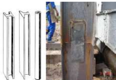
Figura – Diferentes tipos de seções e detalhe de uma emenda entre dois elementos de estaca metálica de seção em “T”.
