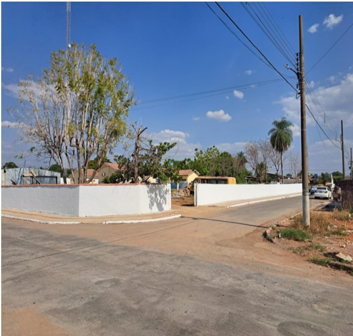
Figura 2- Terreno onde será construída a Delegacia de Nobres
