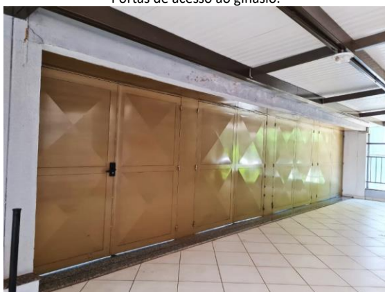
Gradis e estruturas metálicas do ginásio:
