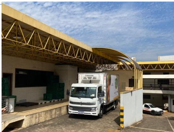
Corrimões e gradis internos e externos:
