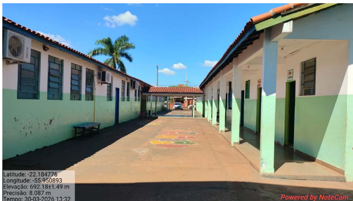
Foto 05: vista interna do pátio
