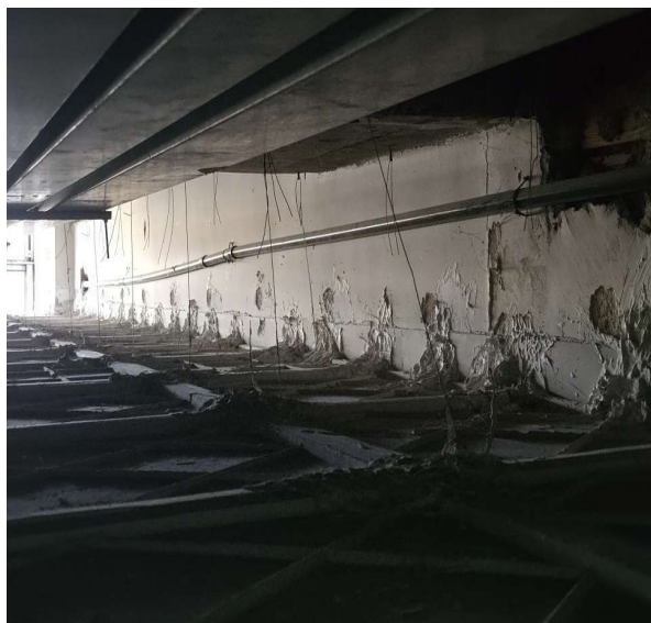
Acesso Laje, detalhe eletrocalhas e forro de gesso
