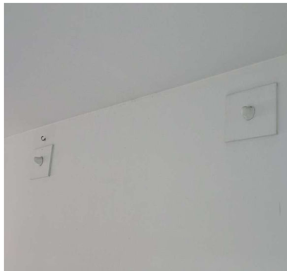
Ancoragem unidades condensadoras
