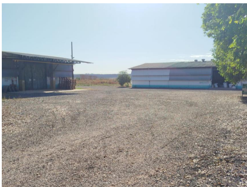
Figura 3: Entrada da Central de Recebimento de Embalagens Agrícolas.
