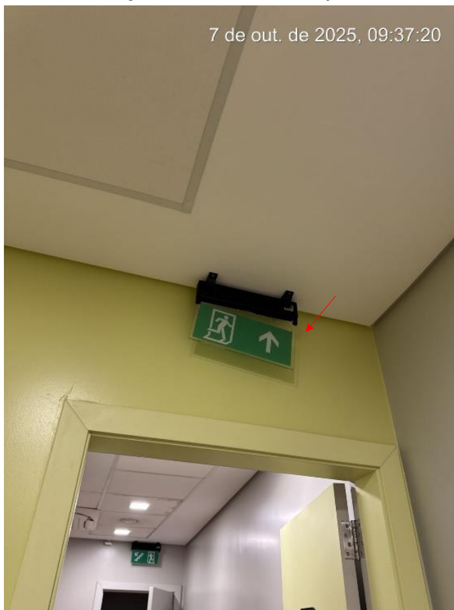
Figura 14 – Placa de identificação solta
