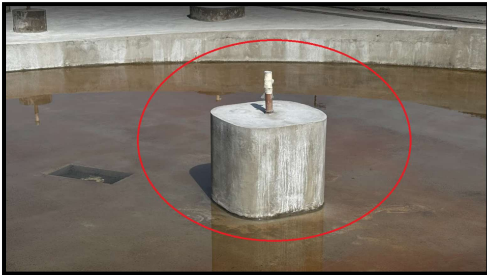
IMAGEM DA BASE – LOCAL DE INSTALAÇÃO:
