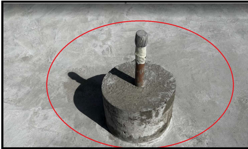
IMAGEM DA BASE – LOCAL DE INSTALAÇÃO:
