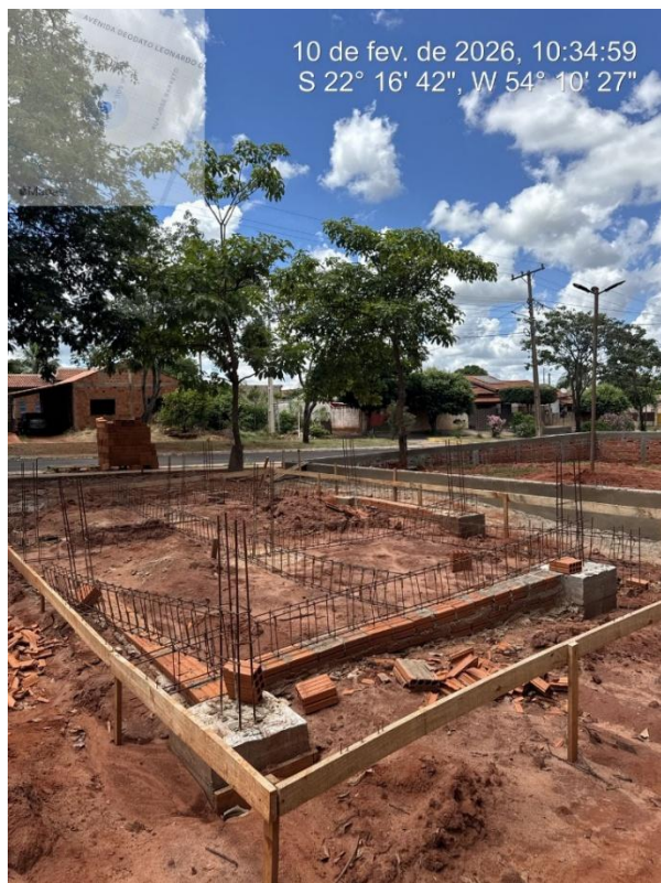
Imagens 04 e 05 – Locação da obra, fundações dos banheiros e estrutura de contenção do parque infantil. Fonte: Acervo próprio.
