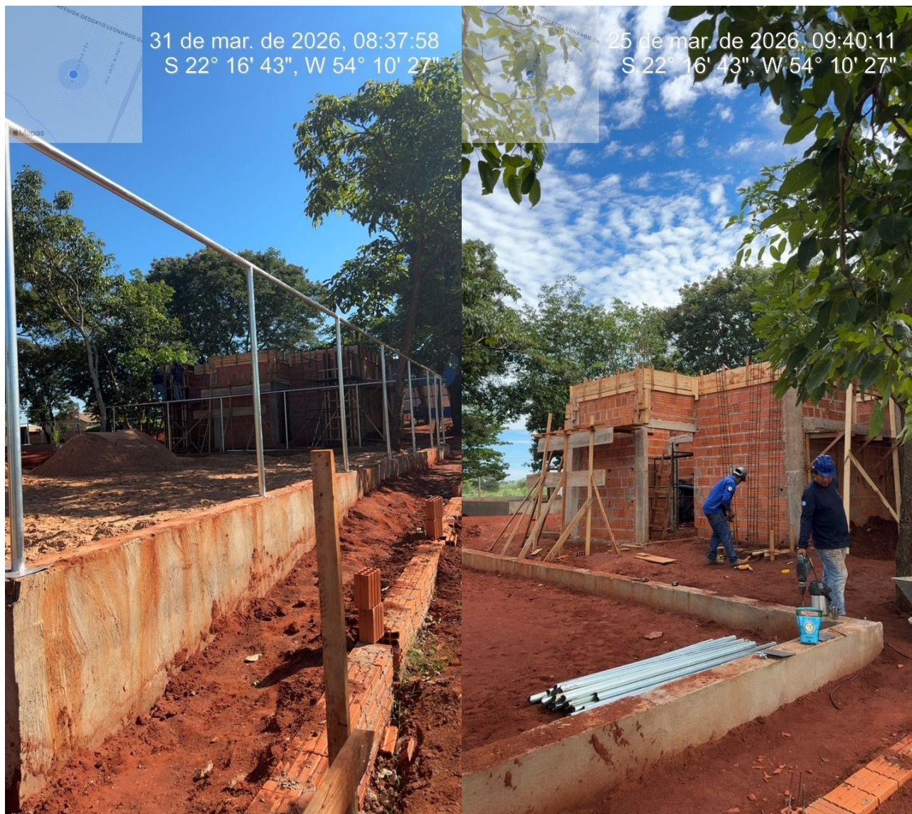
Imagens 14 e 15 – Estrutura dos do parque infantil, alambrado, estrutura dos banheiros. Fonte: Acervo próprio.
