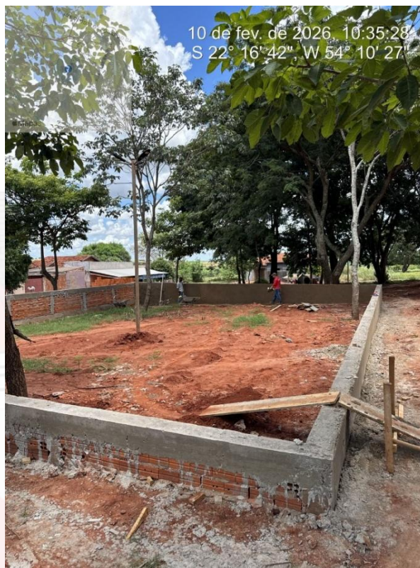
Imagens 04 e 05 – Locação da obra, fundações dos banheiros e estrutura de contenção do parque infantil. Fonte: Acervo próprio.
