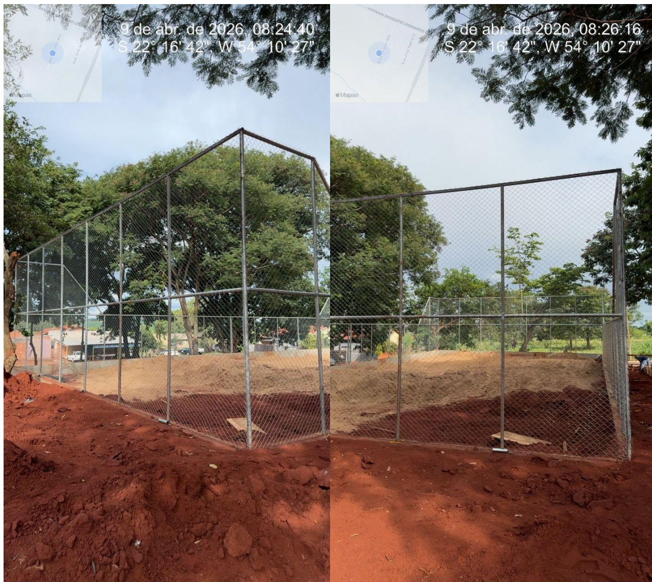
Imagens 18 e 19 – Estrutura da quadra de areia, alambrado. Fonte: Acervo próprio.
