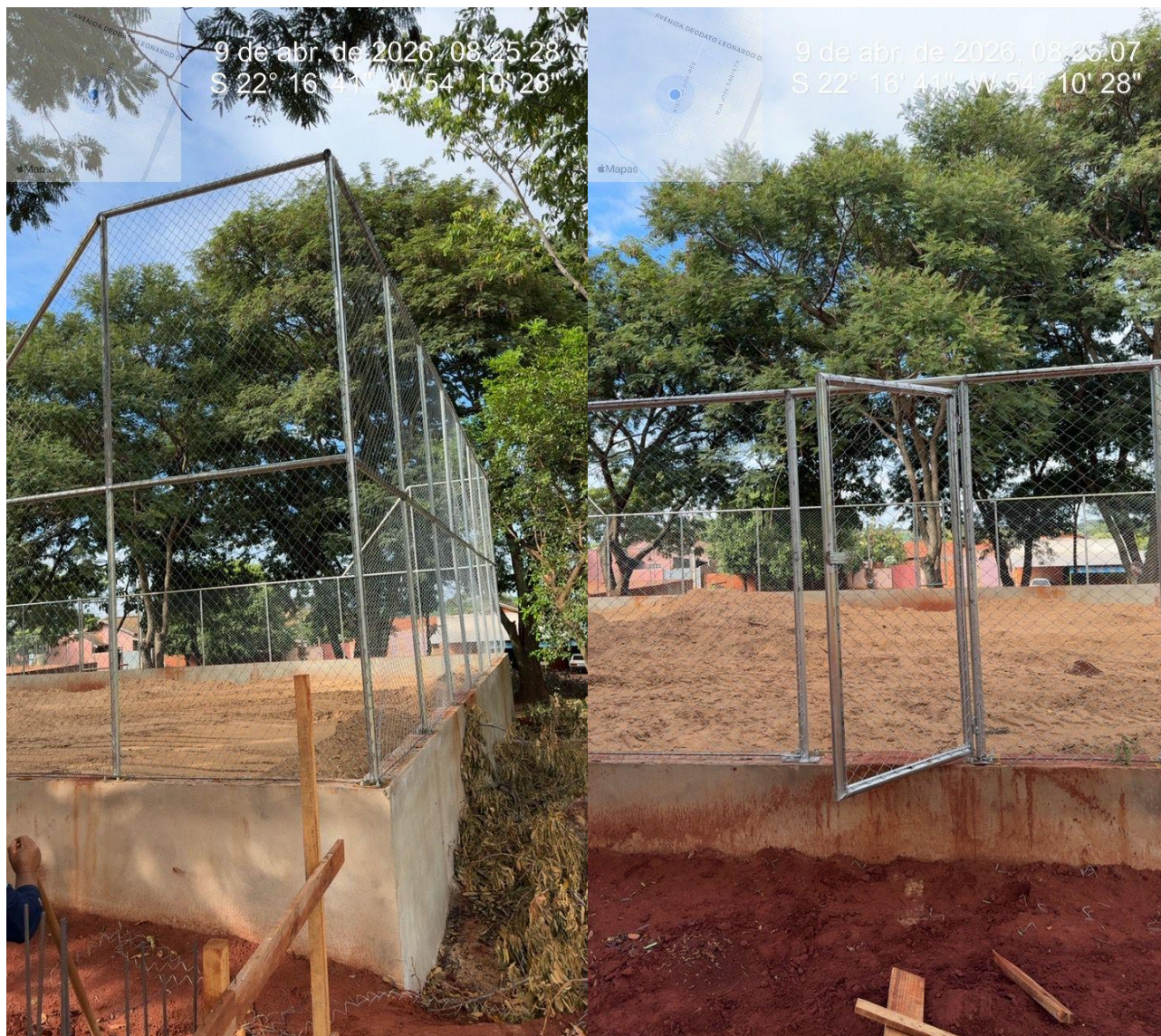
Imagens 16 e 17 – Estrutura da quadra de areia, alambrado. Fonte: Acervo próprio.
