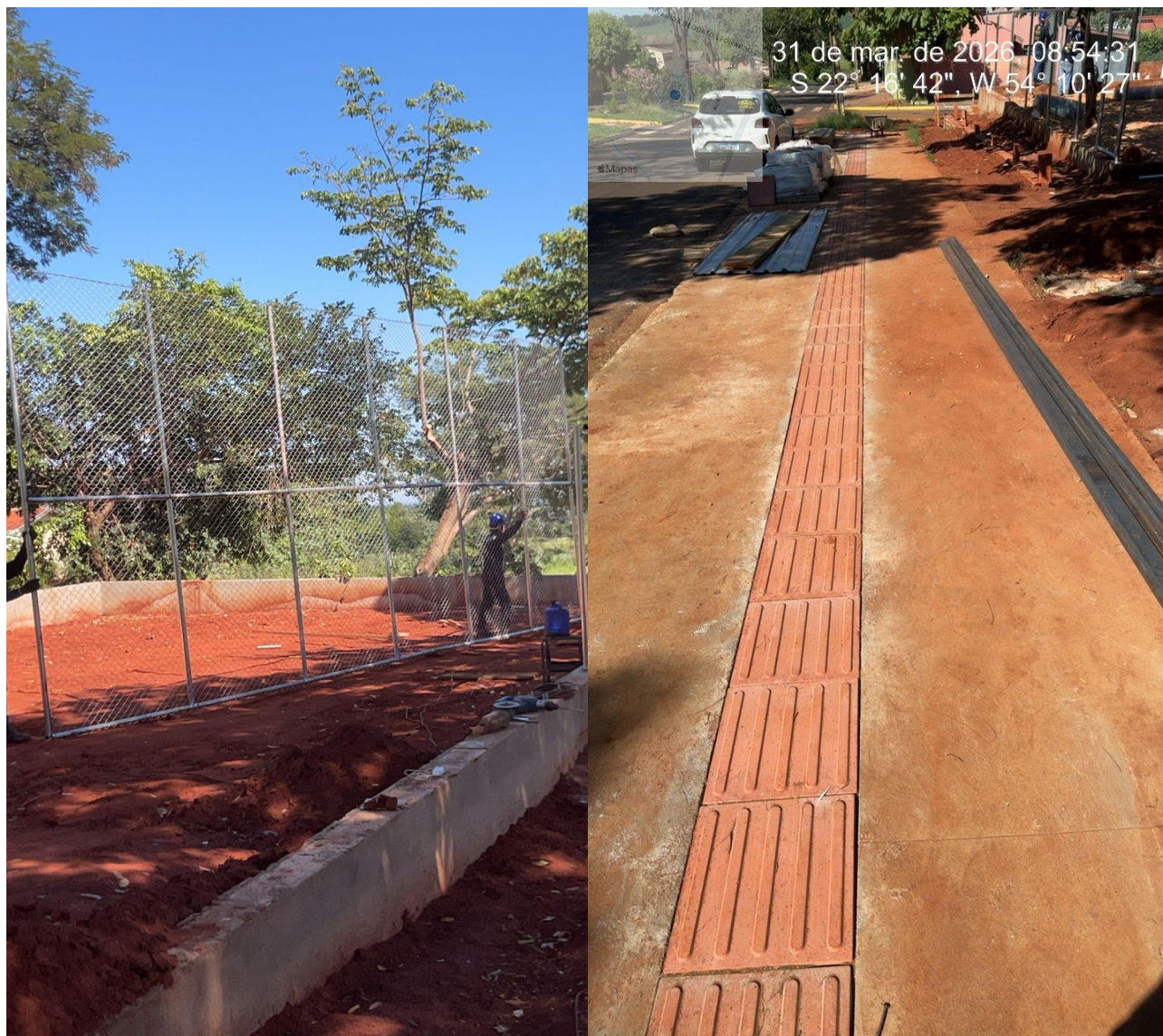
Imagens 12 e 13 – Estrutura da quadra de areia, alambrado, calçadas do passeio público e piso tátil. Fonte: Acervo próprio.
