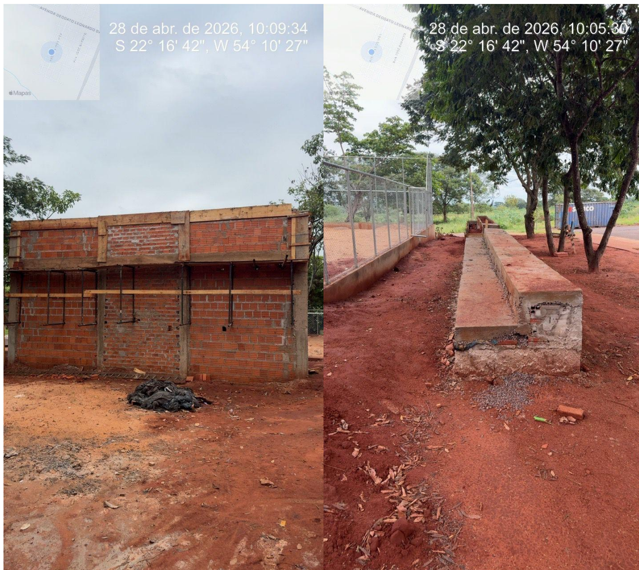
Imagens 24 e 25 – Estrutura dos banheiros, arquibancada. Fonte: Acervo próprio.
