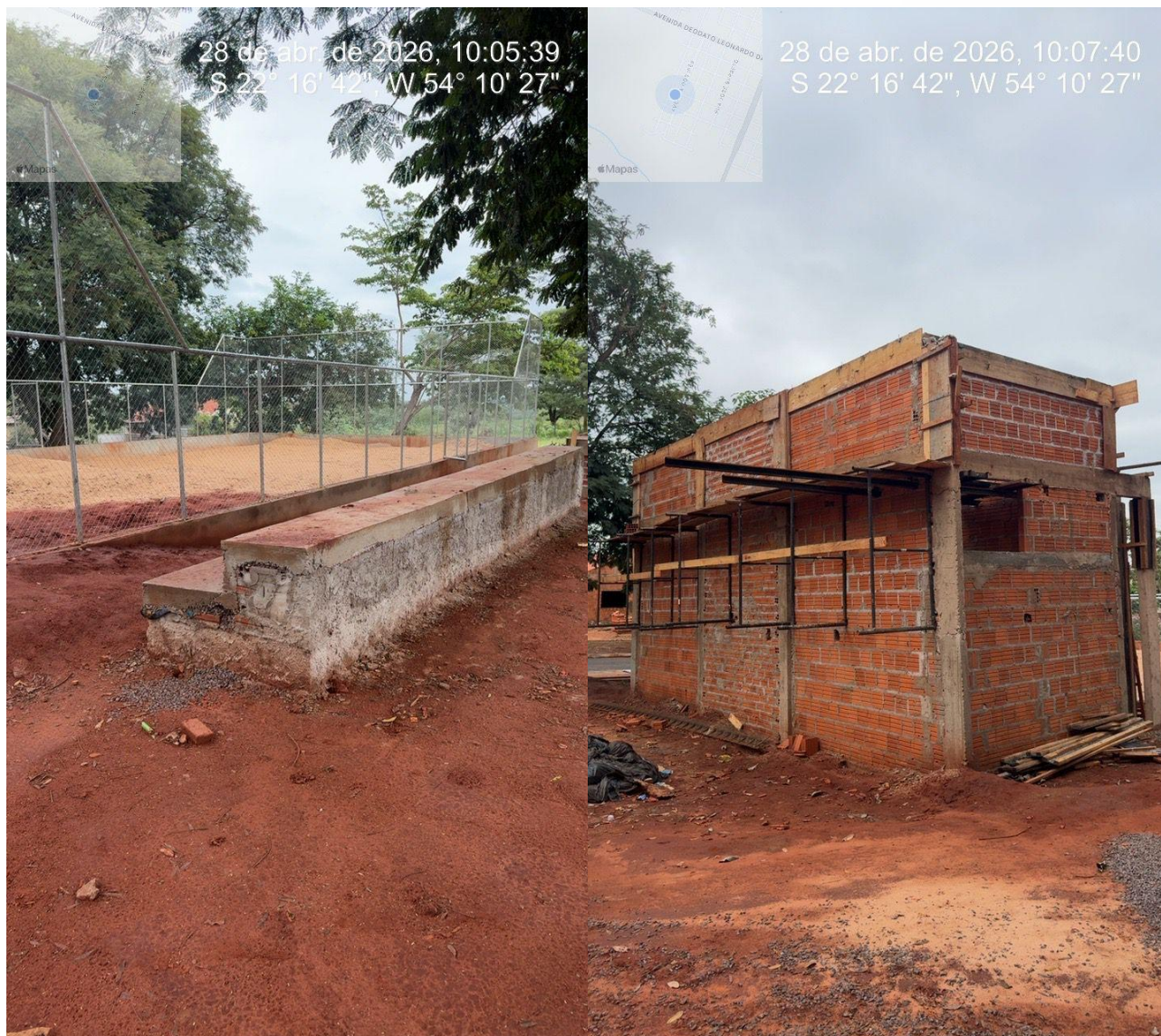
Imagens 20 e 21 – Estrutura da quadra de areia, alambrado, arquibancada e estrutura dos banheiros. Fonte: Acervo próprio.
