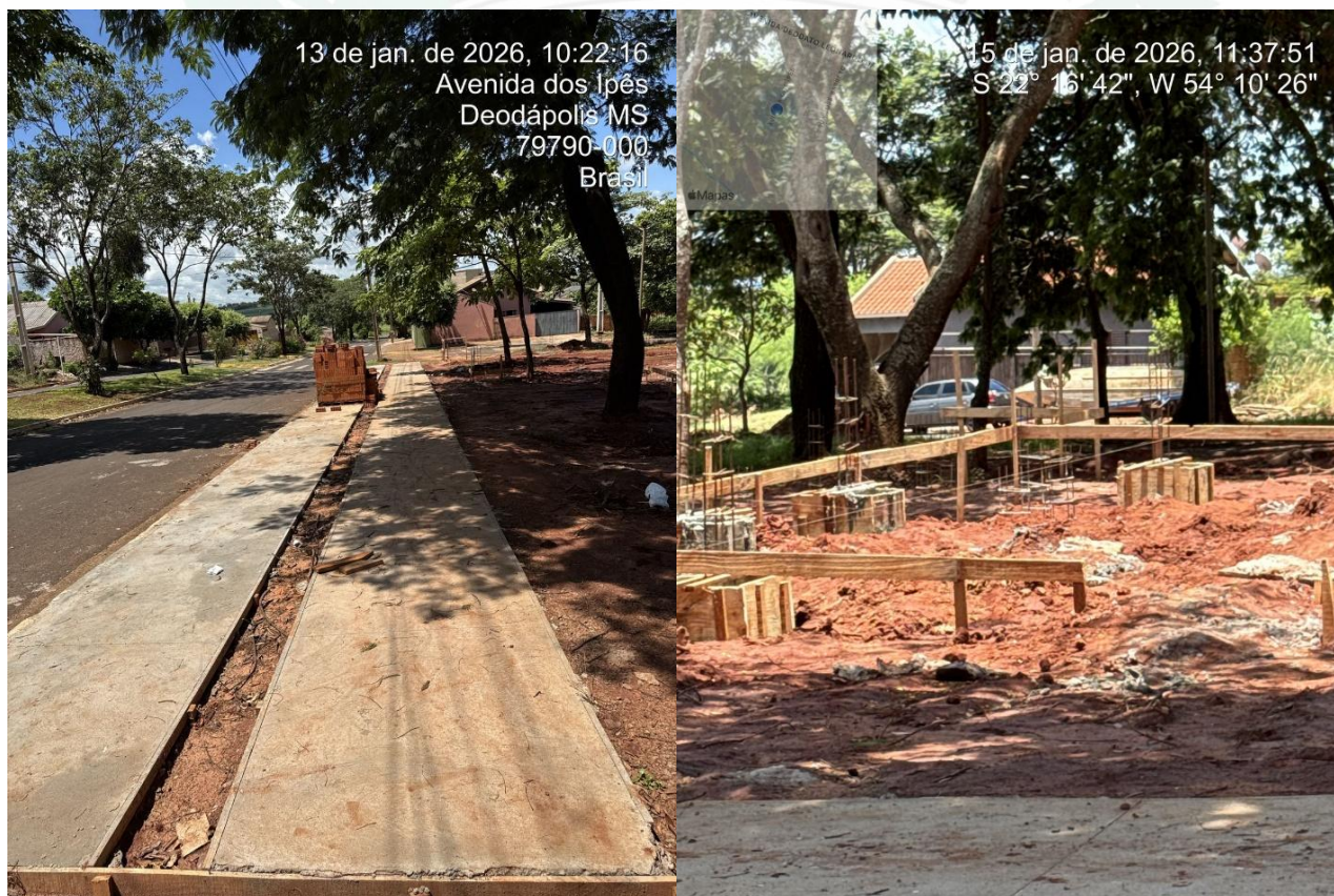
Imagens 02 e 03 – Calçadas do passeio público e locação da obra. Fonte: Acervo próprio.
