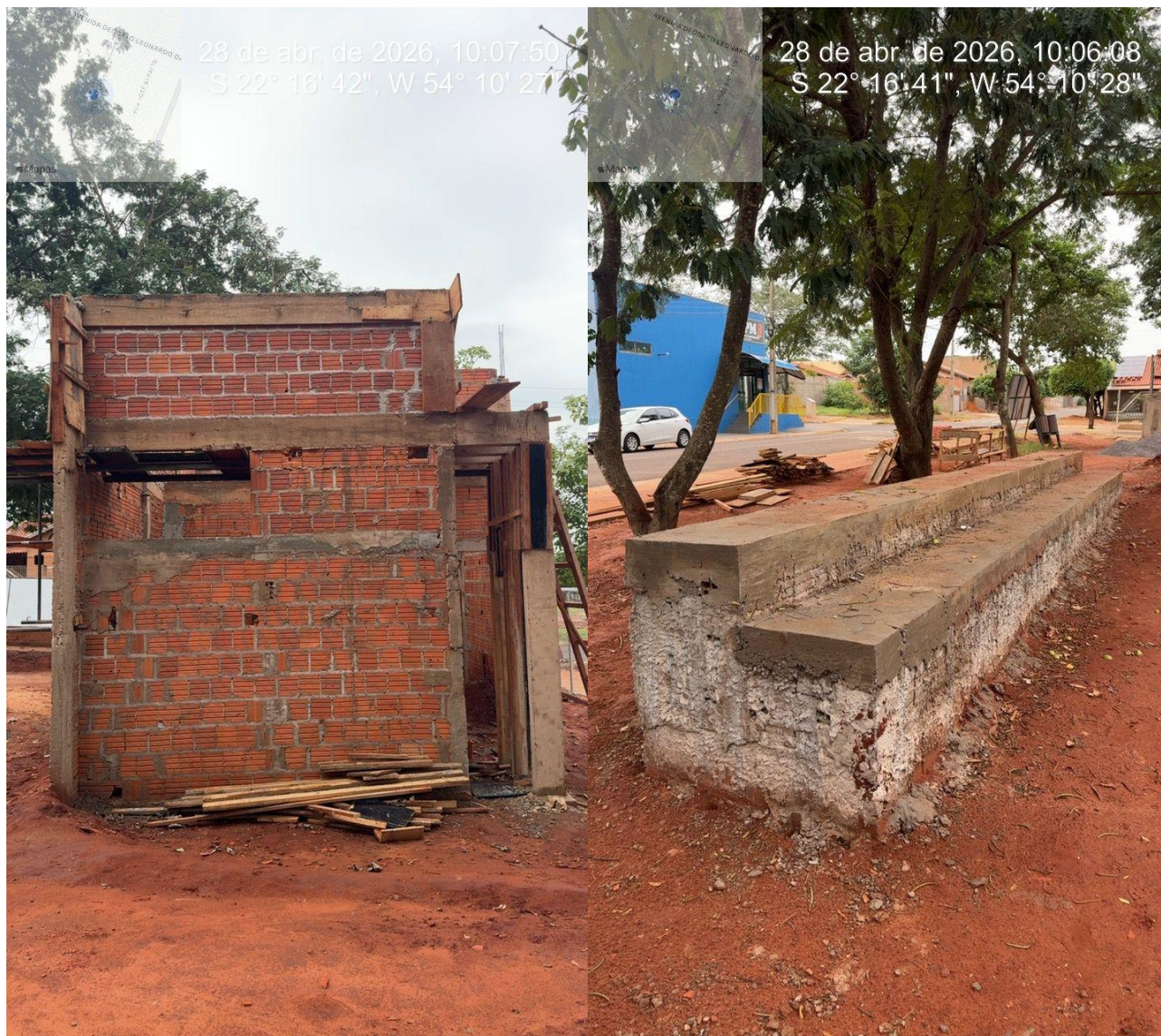
Imagens 22 e 23 – Estrutura dos banheiros, arquibancada. Fonte: Acervo próprio.
