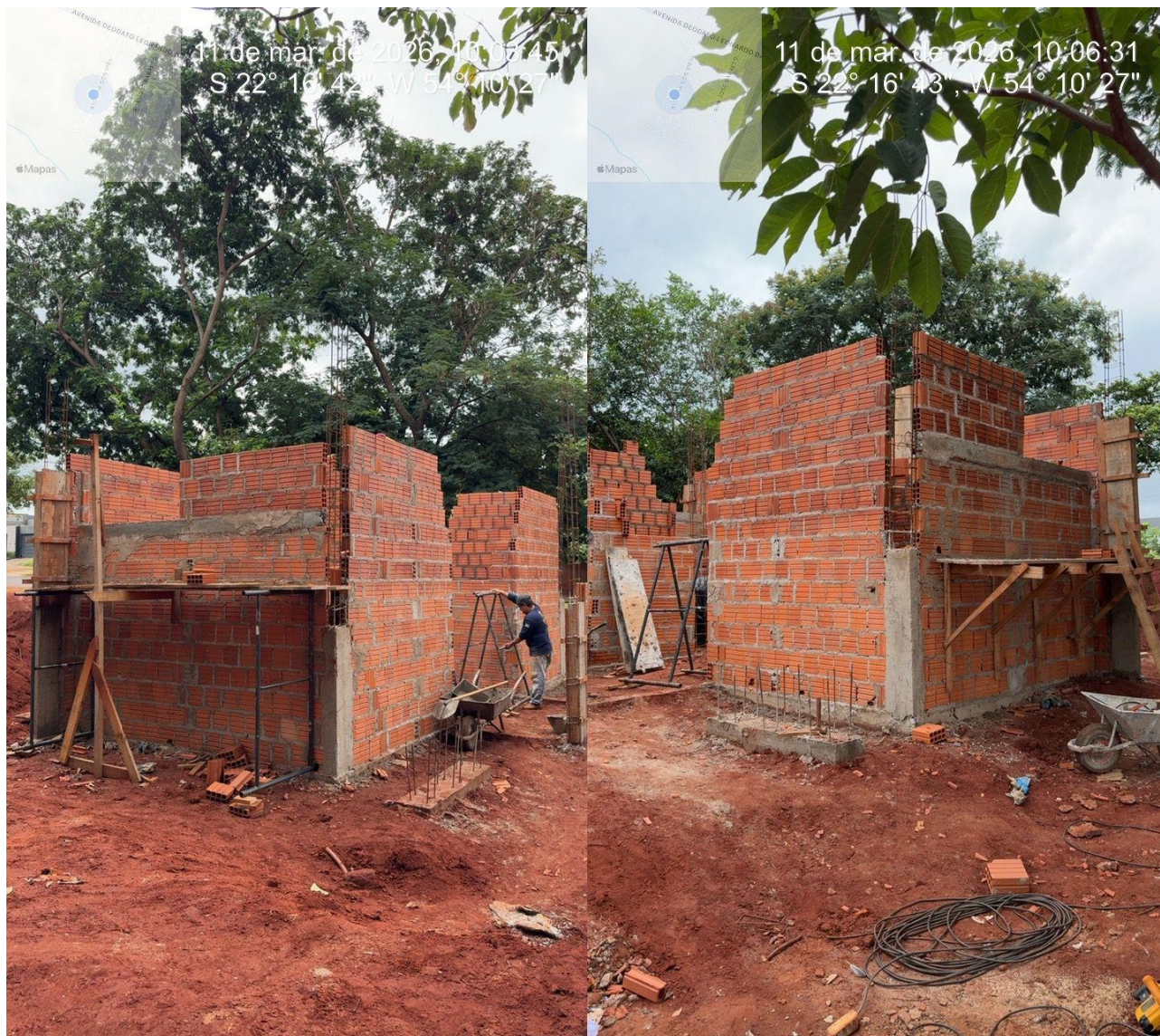
Imagens 10 e 11 – Estrutura dos banheiros. Fonte: Acervo próprio.
