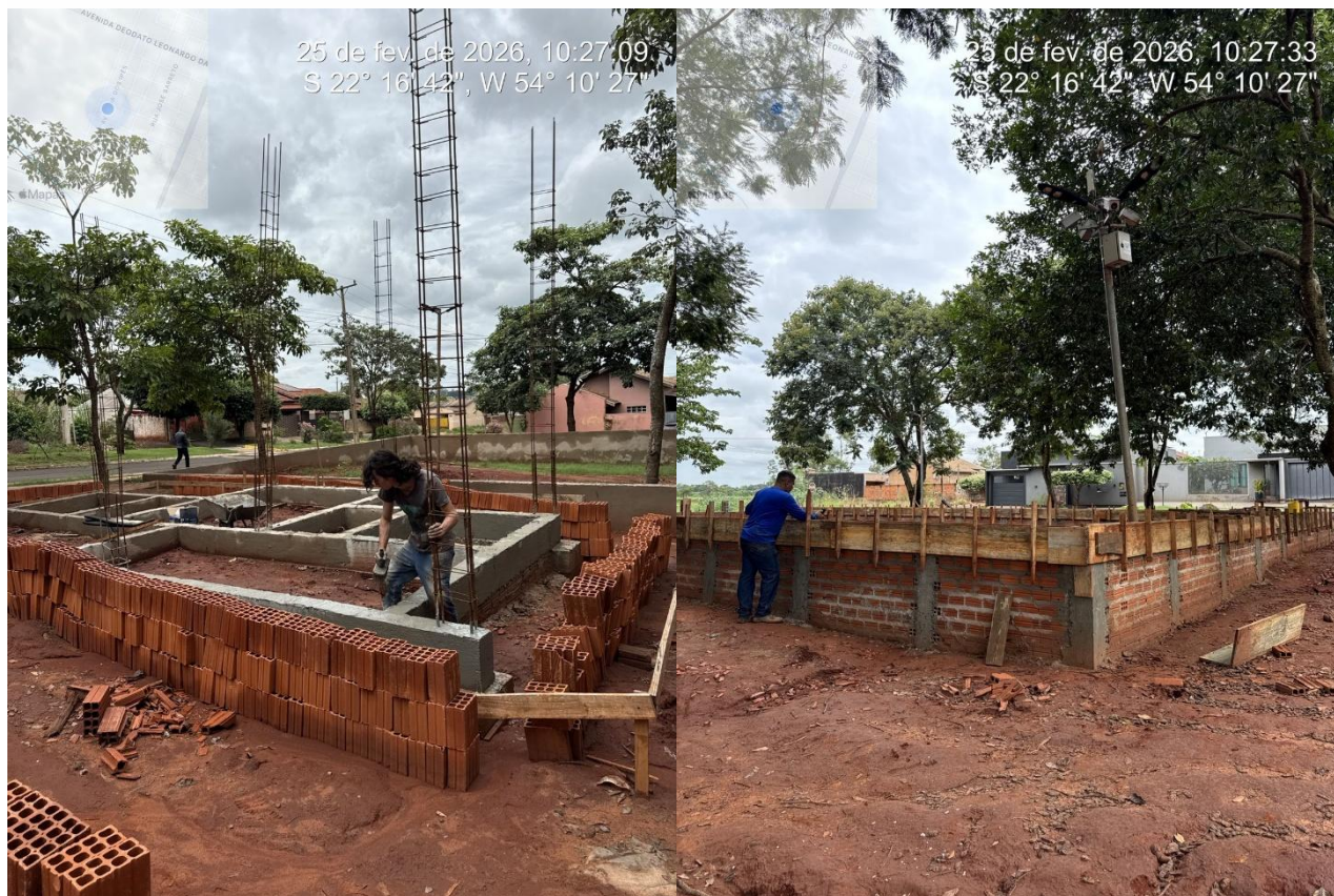
Imagens 08 e 09 – Estrutura dos banheiros e estrutura de contenção do parque infantil. Fonte: Acervo próprio.
