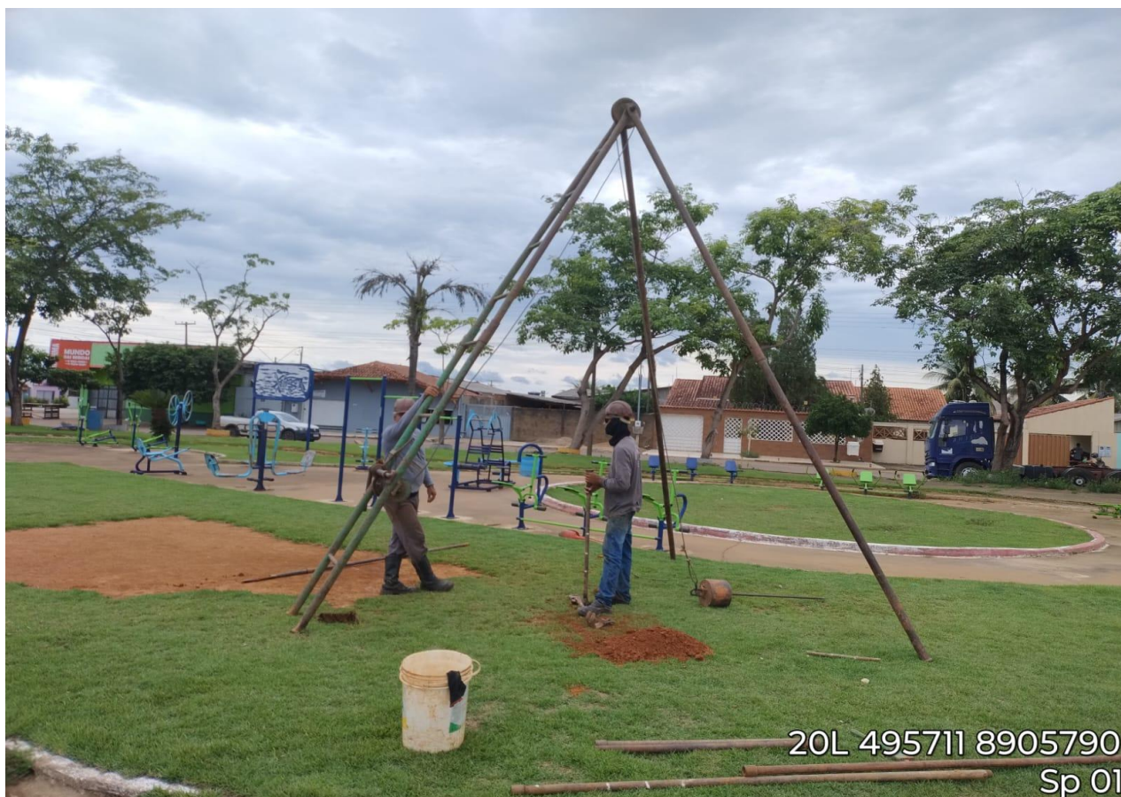
Foto 02 - Furo SP001 - execução do procedimento de sondagem e reconhecimento de subsolo.
