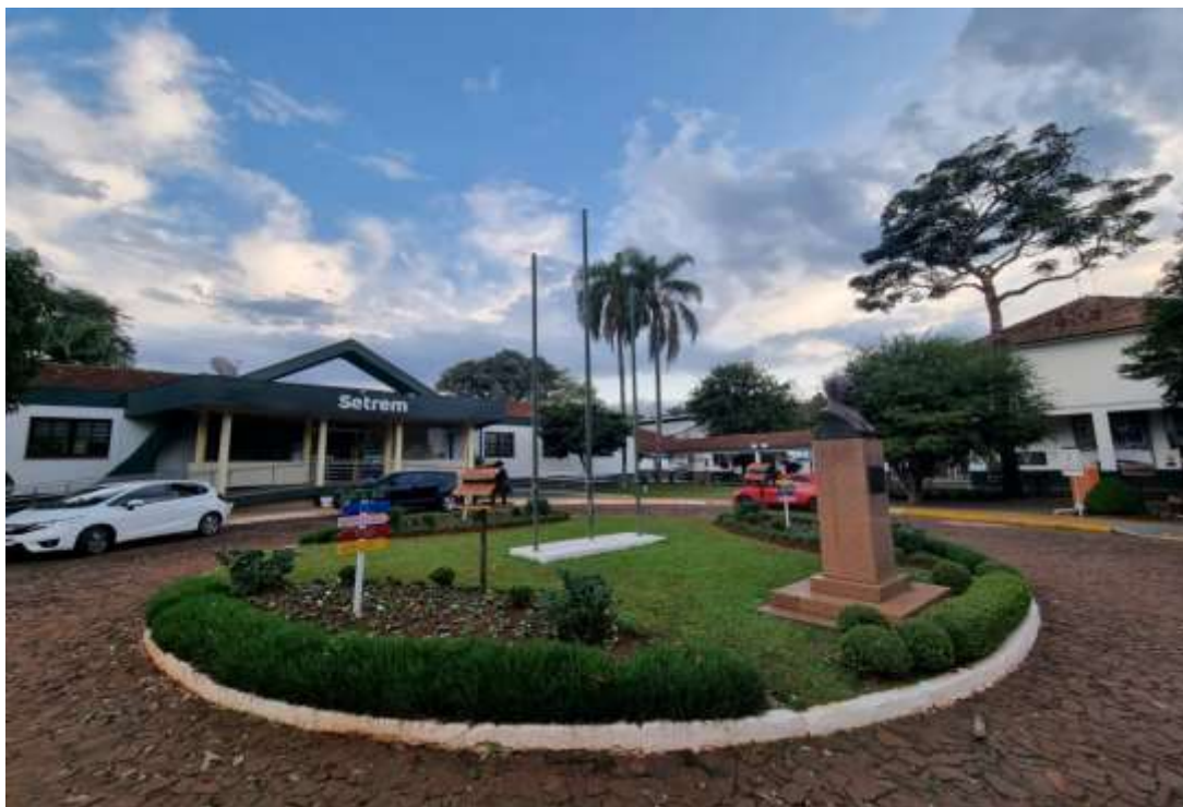
Foto: Prédio Administrativo. Fonte: Setor de Comunicação
