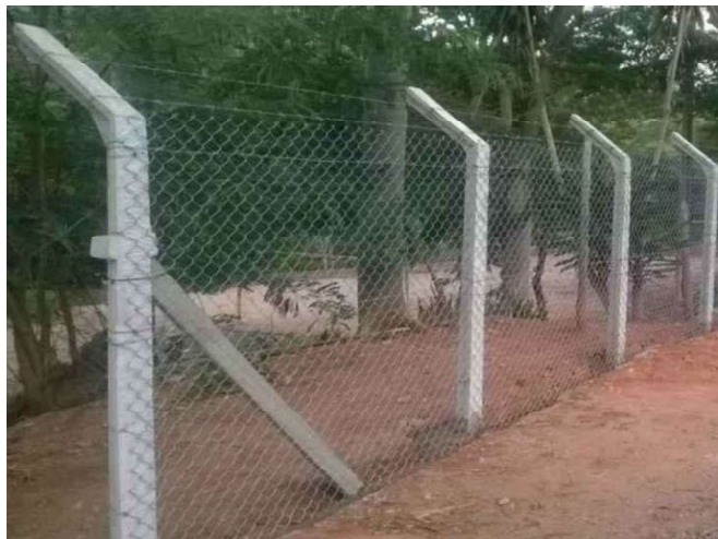
Figura 2: Escoras de fixação nos cantos.
