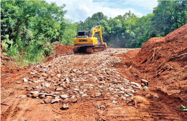
Máquinas concluíram o acesso ao Morro Gaúcho na última semana
