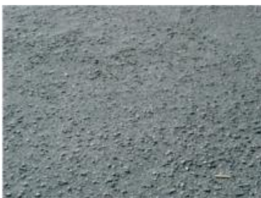
Figura 04 – Falhas de adesividade ligante-agregado
