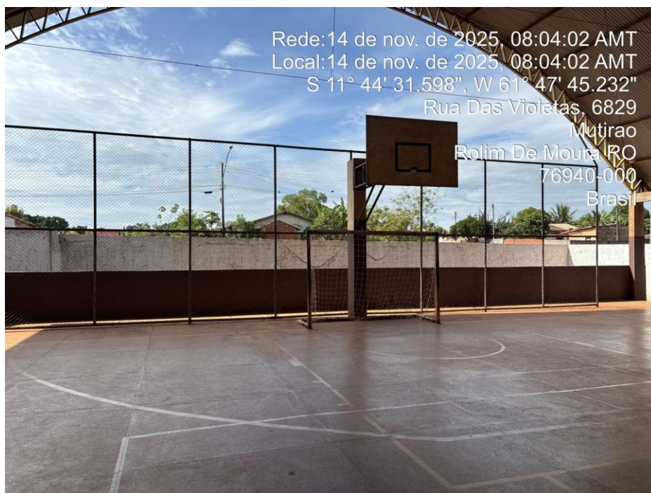
REFORMAR DA QUADRA (PINTURAS, LIXAMENTO E RESINAGEM)
