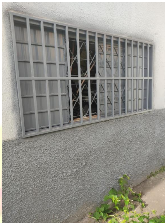
Figura 2 – Janela e parede a serem demolidas
