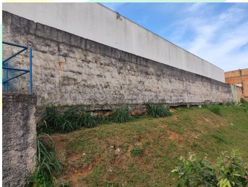
Figura 5 – Muro a ser demolido e talude a ser cortado
