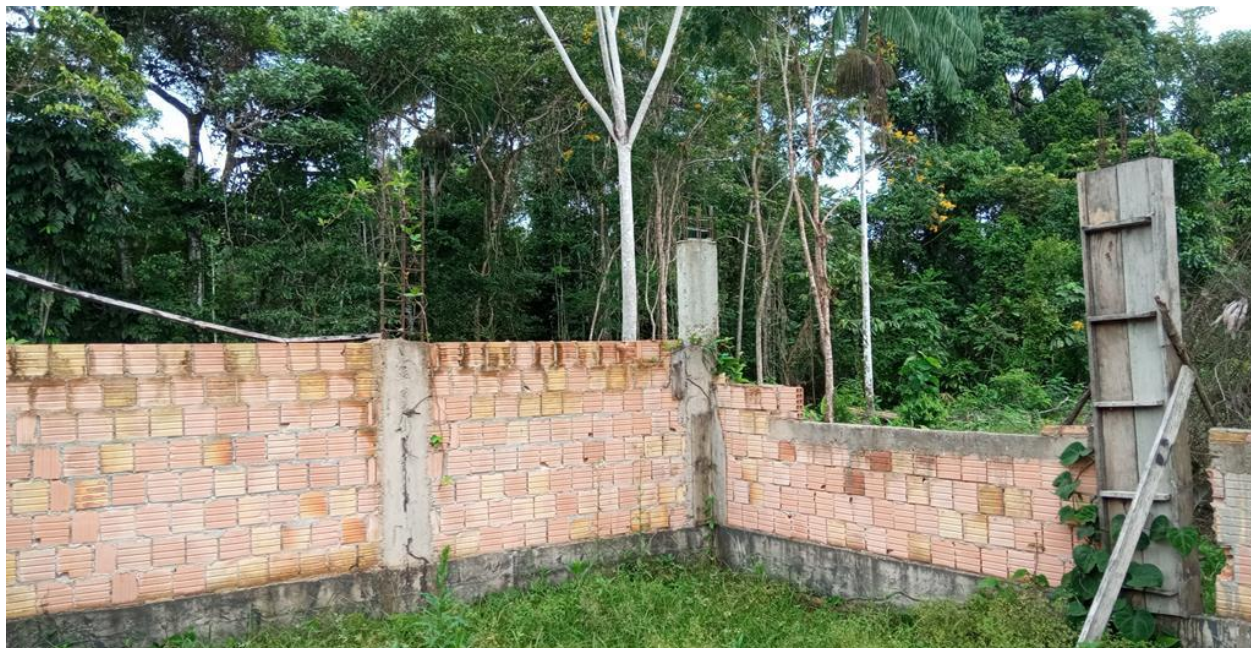
Figura 32 – Inconformidade gerada no Simec conforme fiscal do FNDE, alvenaria do bloco pedagógico executada sem amarração. Fonte: vistoria in loco.
