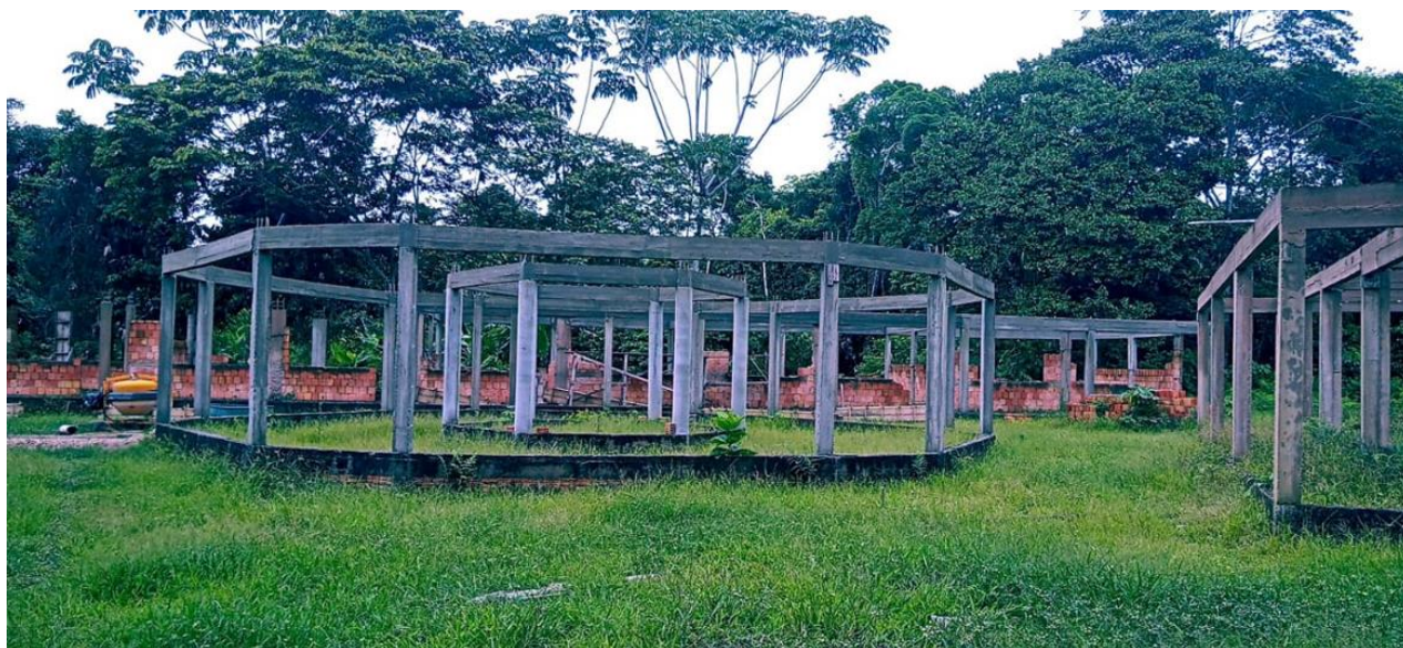
Figura 23 – Foto do bloco central inacabado. Fonte: vistoria in loco.
