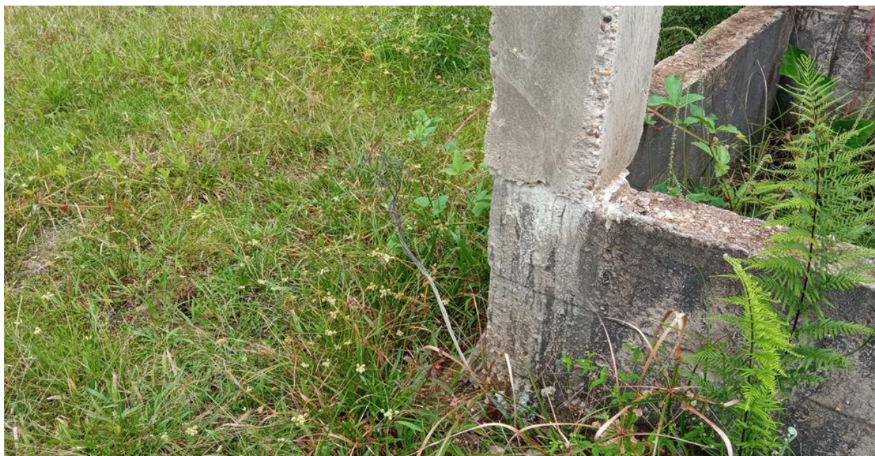
Figura 34 – Inconformidade gerada no Simec conforme fiscal do FNDE, corrigir execução do SPDA, ao invés dos ferros CA-25 de 10mm 2 foram executadas cordoalhas de aço como descida do para-raios. Fonte: vistoria in loco.
