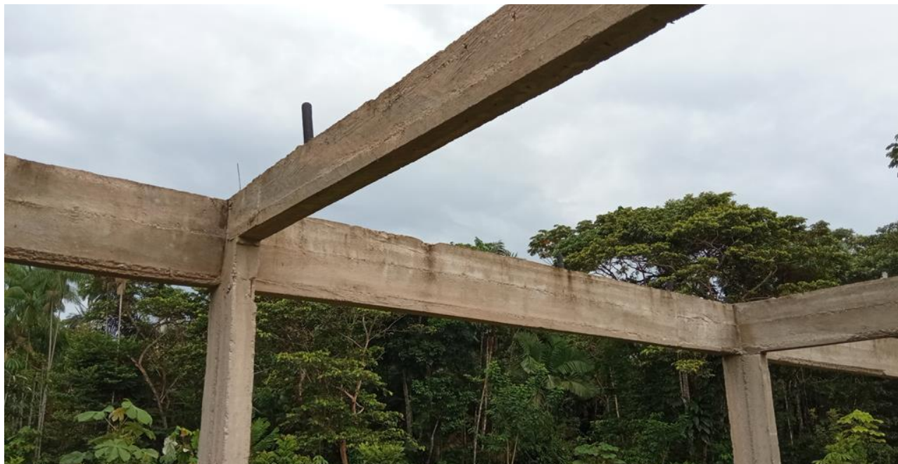
Figura 30 – Inconformidade gerada no Simec conforme fiscal do FNDE, passagens para instalações elétricas em desconformidade perfurando as vigas. Fonte: vistoria in loco.
