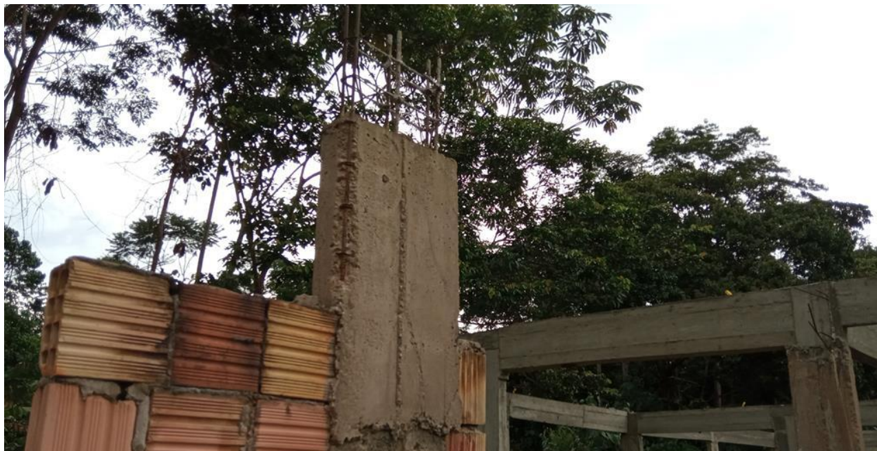
Figura 28 – Inconformidade gerada no Simec conforme fiscal do FNDE, pilares mal concretados, alguns concretados parcialmente, o que irá gerar juntas de concretagem. Fonte: vistoria in loco.
