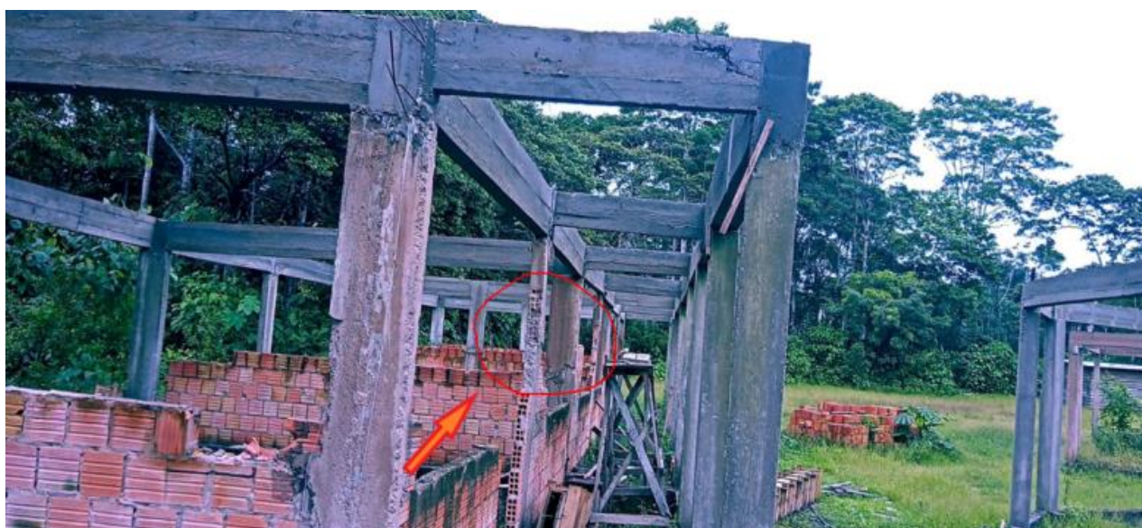
Figura 9 – Falta de revestimento, recuperar pilares danificados. Fonte: vistoria in loco.
