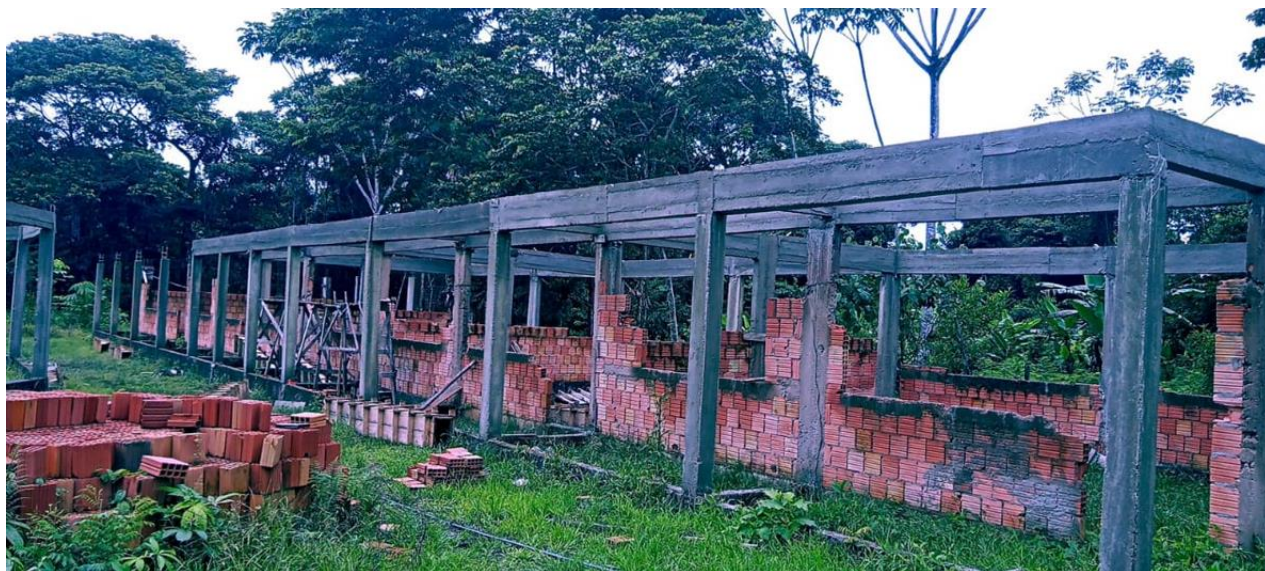
Figura 17 – Alvenaria executada sem amarração (bloco pedagógico). Fonte: vistoria in loco.
