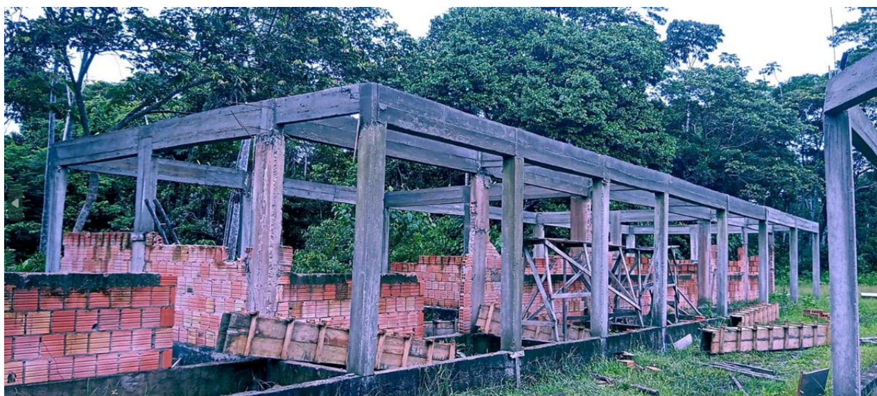
Figura 11 – Executar as vigas que ainda faltam (bloco pedagógico). Fonte: vistoria in loco.
