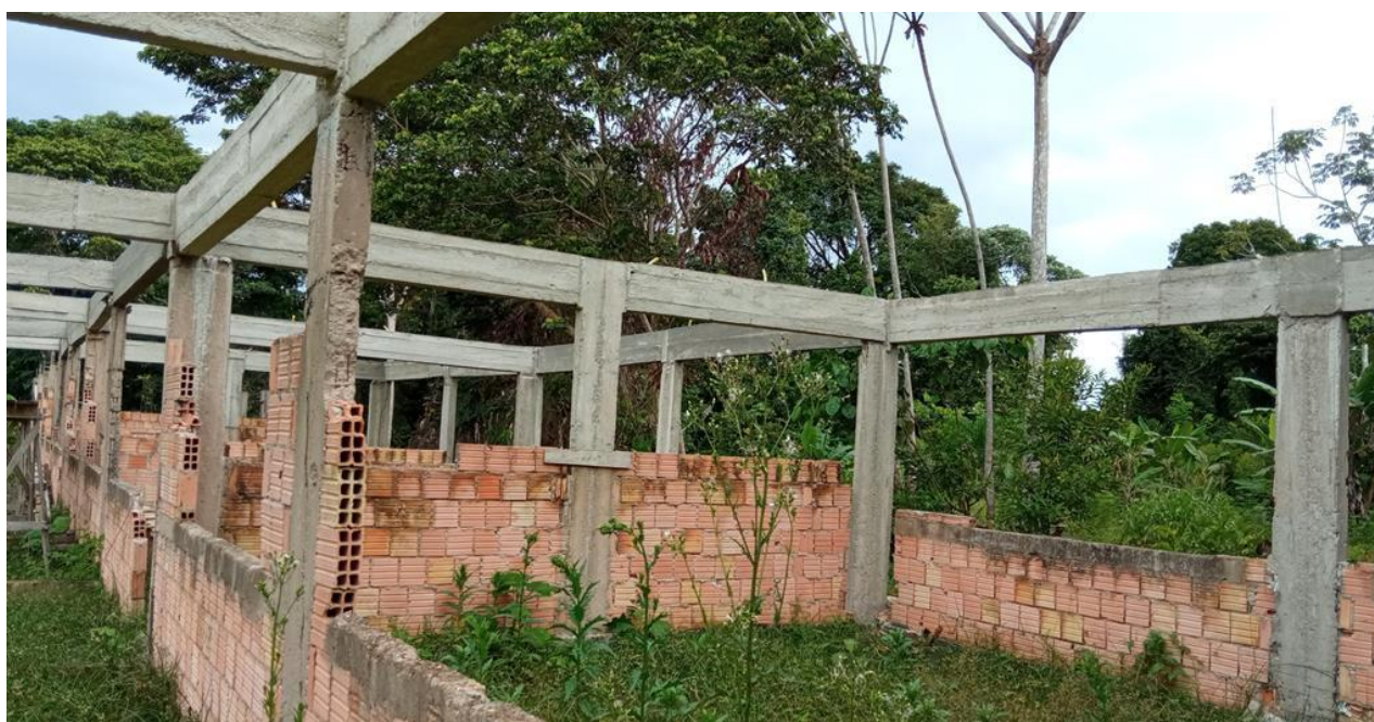
Figura 29 – Inconformidade gerada no Simec conforme fiscal do FNDE, vigas com armações aparentes e superfícies irregulares. Fonte: vistoria in loco.
