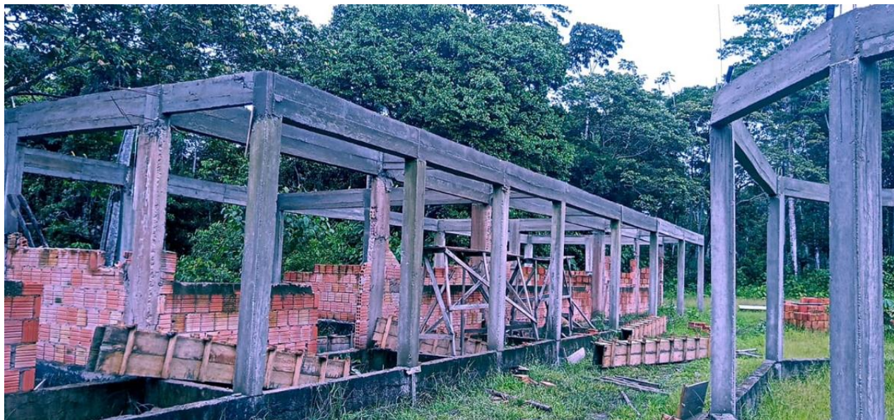
Figura 10 – Foto da superestrutura bloco pedagógico. Fonte: vistoria in loco
