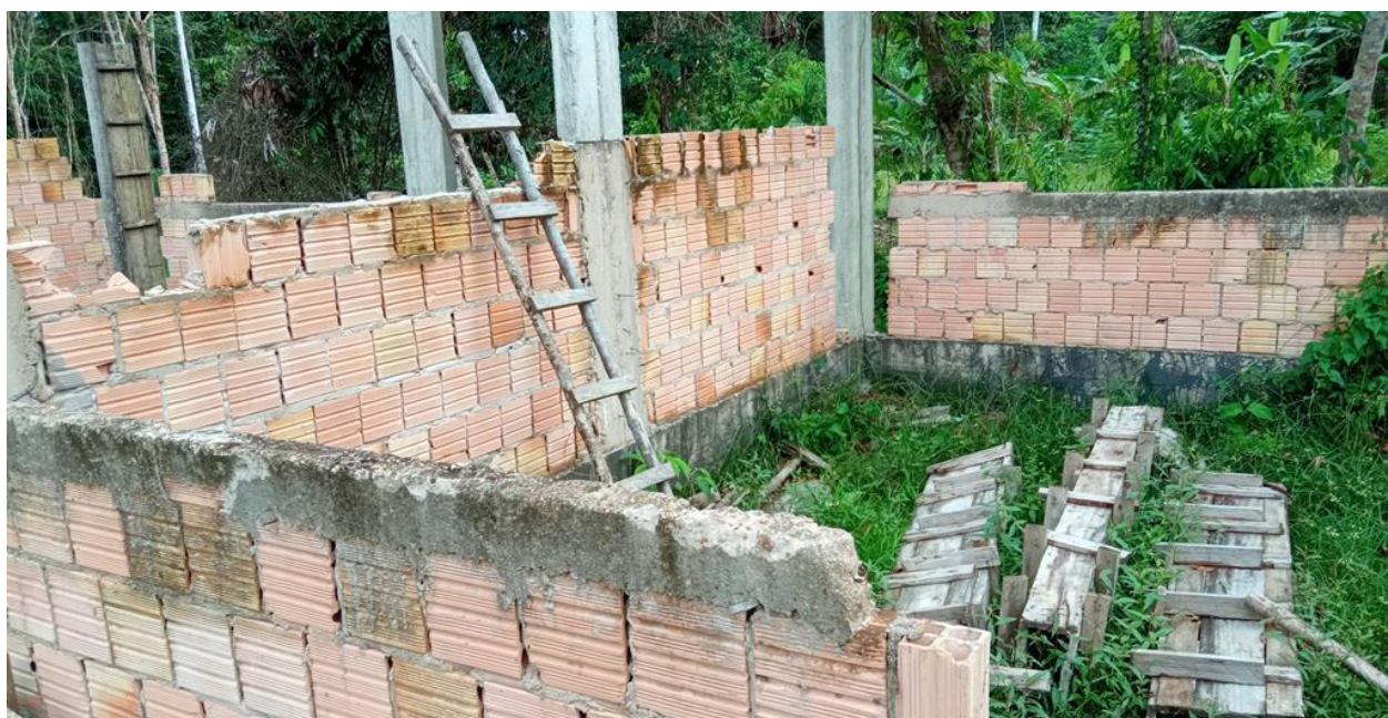
Figura 33 – Inconformidade gerada no Simec conforme fiscal do FNDE, refazer contravergas quebradas. Fonte: vistoria in loco.
