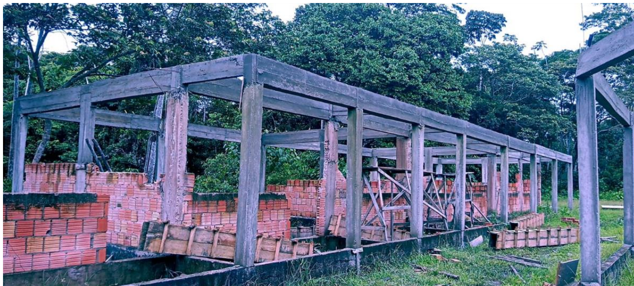
Figura 16 – Alvenaria executada sem amarração (bloco pedagógico). Fonte: vistoria in loco.
