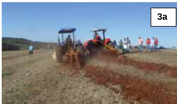
Figura 3a - Primeira série de passadas de tratores com arados de disco para construção do camalhão do terraço; Figura 3b. Segunda série de passadas
