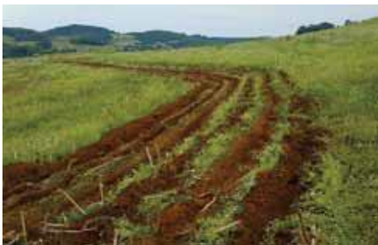
Figura 6 - Zona de corte escarificada, seguindo a marcação das estacas.
