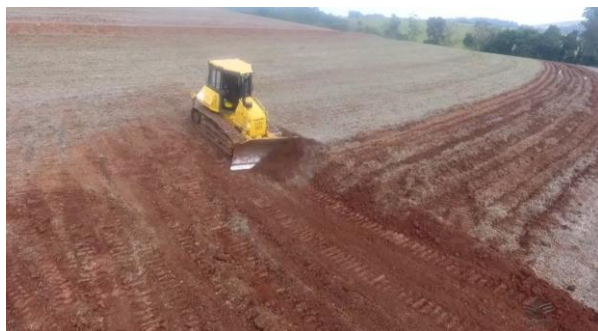
Figuras 7 - Movimentação de solo (de cima para baixo) em direção da linha de demarcação do terraço para formação do camalhão.
