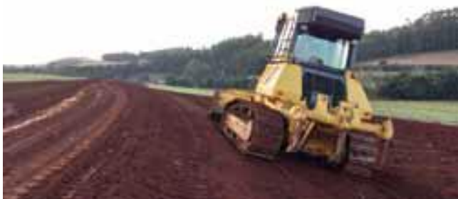
Figuras 8 - Acabamento longitudinal na zona de corte e aterro do terraço.
