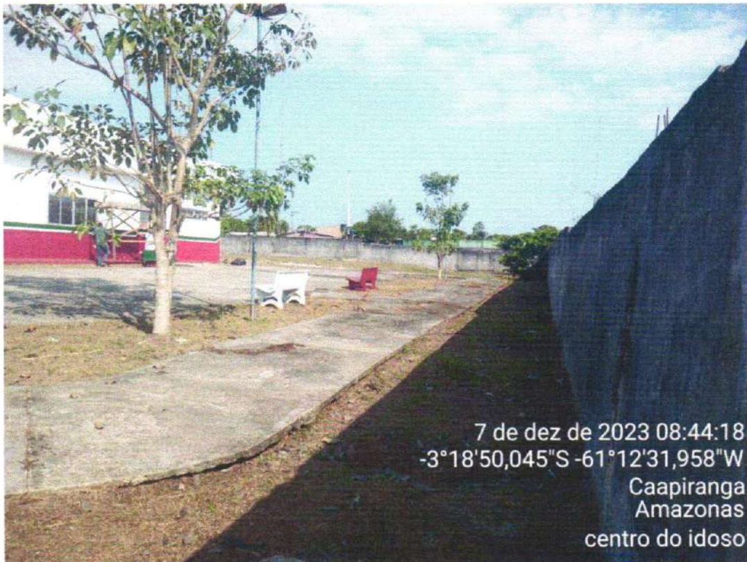
FOTO 41 ÁREA DE AMPLIAÇÃO/ FACHADA LATERAL
