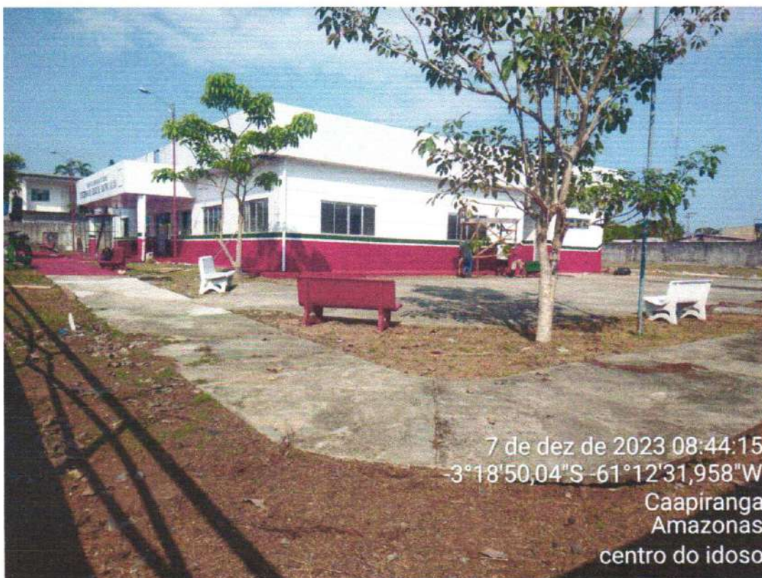
FOTO 42 ÁREA DE AMPLIAÇÃO/ FACHADA LATERAL
