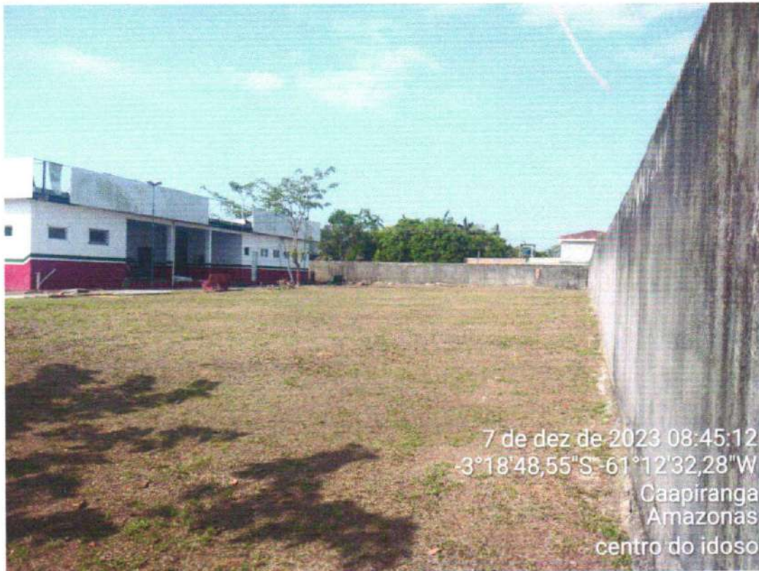
FOTO 40 ÁREA DE AMPLIAÇÃO/ FACHADA POSTERIOR
