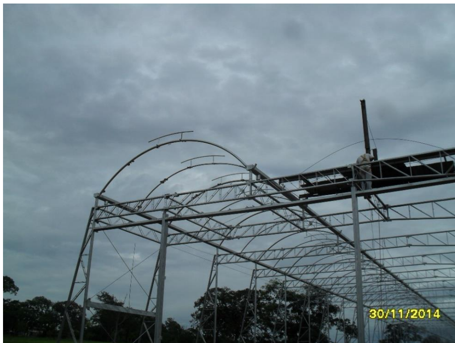
Figura 2 – Foto da Construção em 2014
