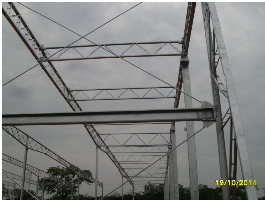
Figura 1 – Foto da construção em 2014
