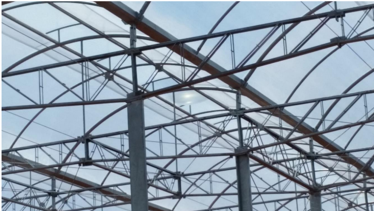
Figura 3 – Foto Atualmente Estrutura em Arco
