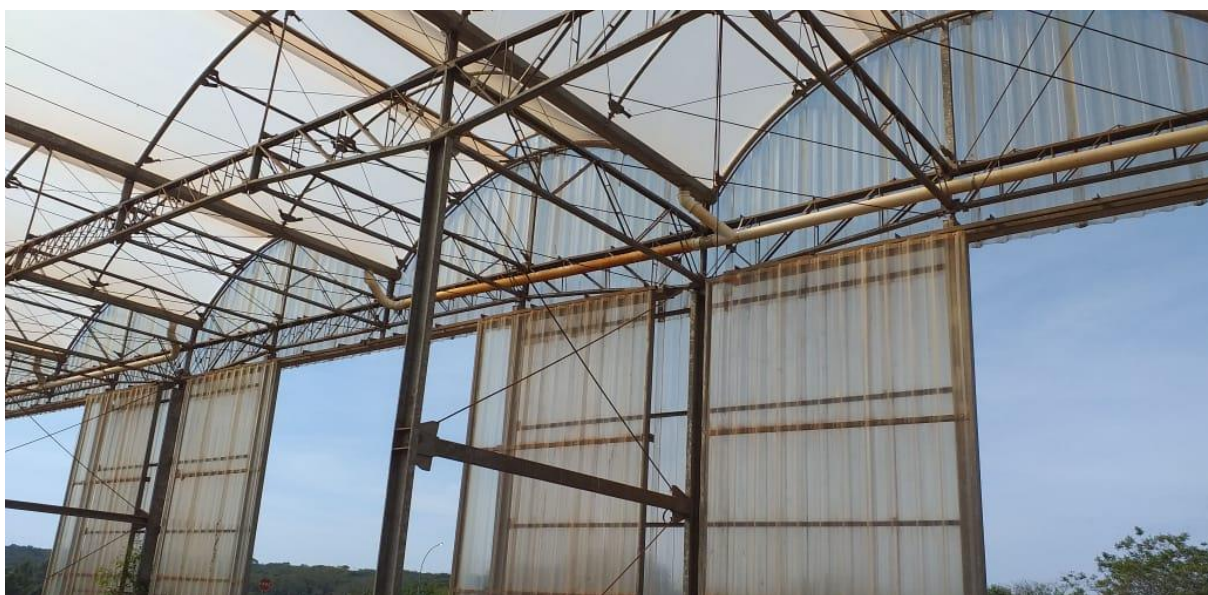
Figura 4 – Foto Atualmente Estrutura em Arco
