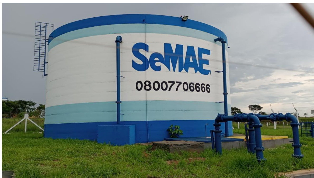
Figura 6 – Reservatório em concreto armado semienterrado.
