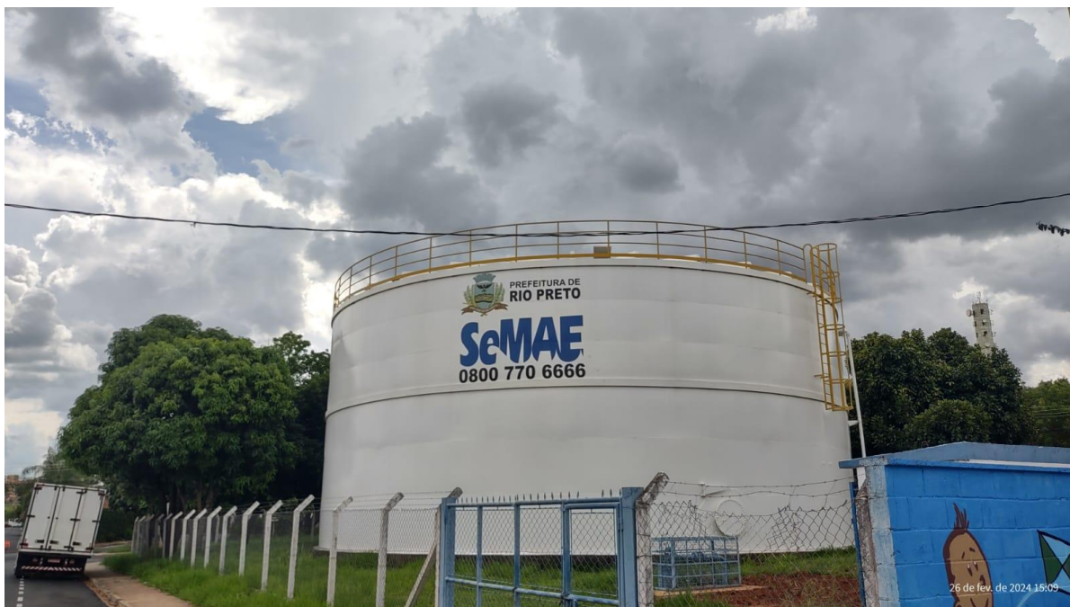
Figura 5 – Reservatório metálico apoiado.
