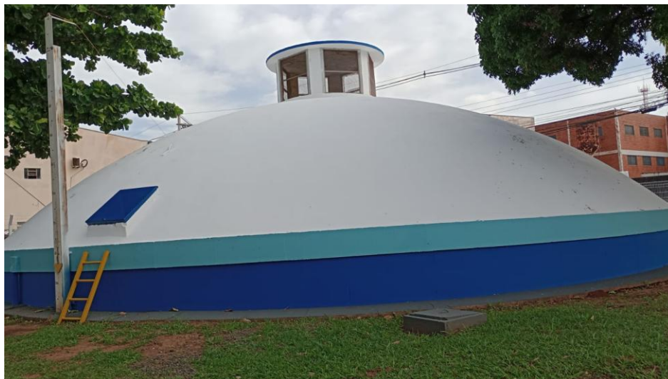
Figura 1 – Reservatório em concreto armado do tipo abóboda.
