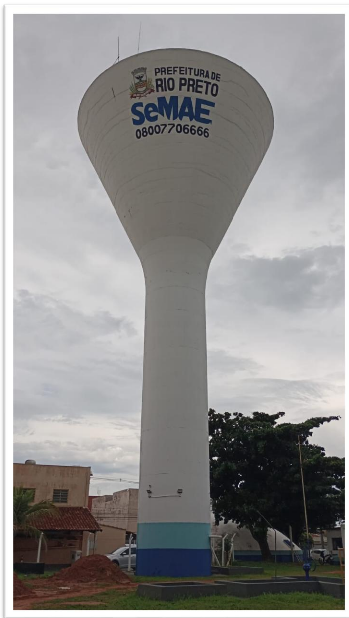
Figura 4 – Reservatório elevado em concreto armado tipo taça.
