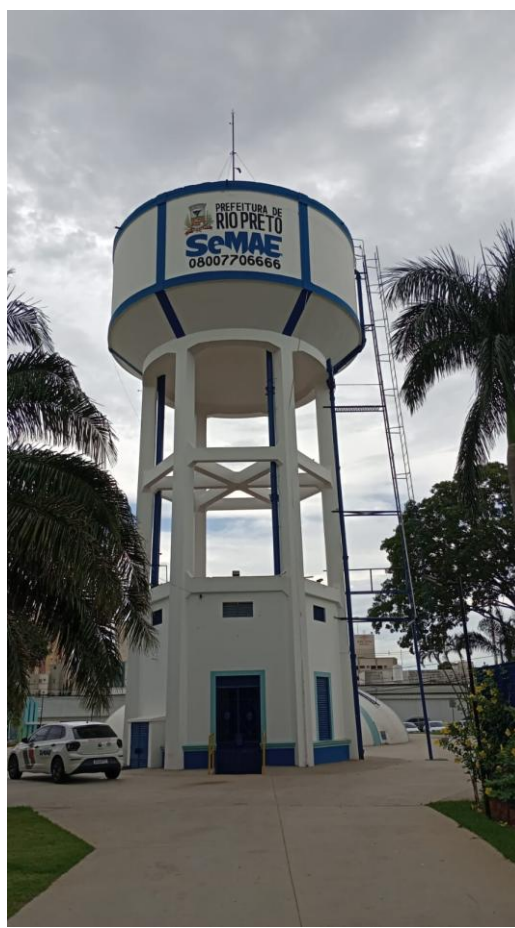
Figura 2 – Reservatório elevado em concreto armado cilíndrico.
