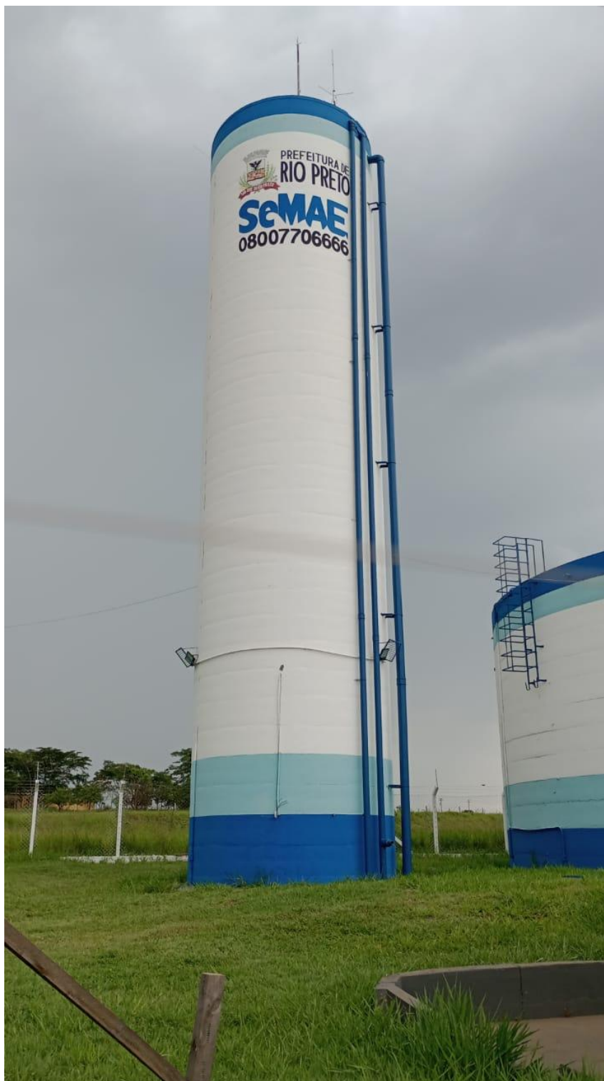
Figura 3 – Reservatório elevado em concreto armado cilíndrico.
