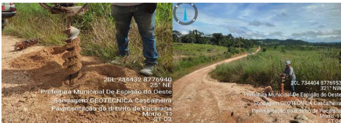
Foto 02: sondagem em sondagem área rural. Fonte: Autor, 2025.
