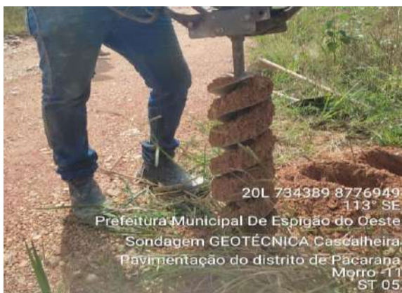
Foto 03: sondagem em sondagem área rural. Fonte: Autor, 2025.
