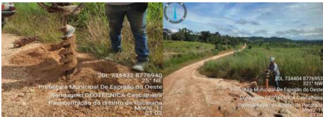
Foto 02: sondagem em sondagem área rural. Fonte: Autor, 2025.
