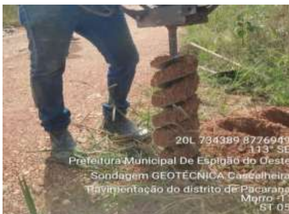
Foto 03: sondagem em sondagem área rural. Fonte: Autor, 2025.
