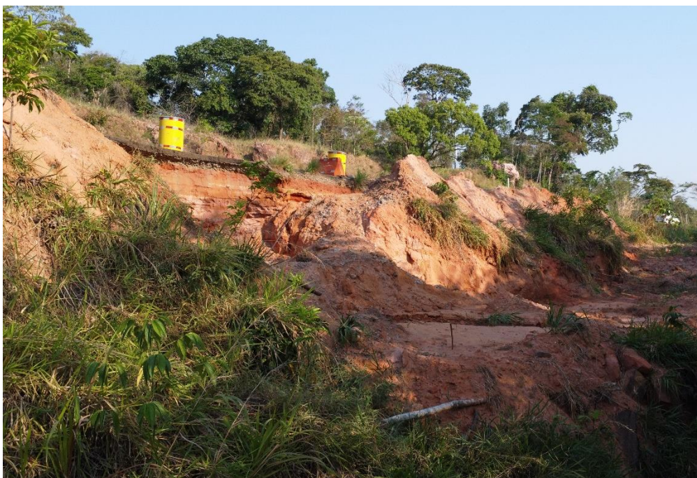
FIGURA 7 – LOCAL DO PROCESSO EROSIVO KM 472,10..
