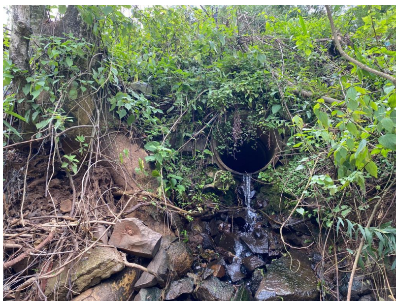
Figura 9 - km 195+500 – Saída de bueiro de travessia.
