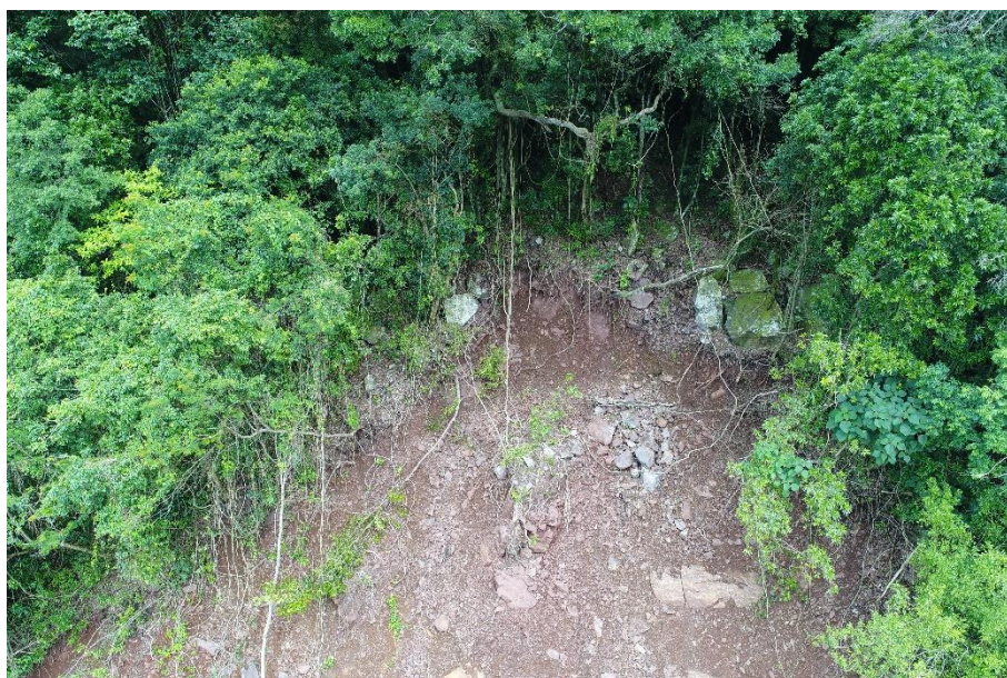
Figura 16 - km 203+000 – Região superior com presença de blocos soltos na crista.
