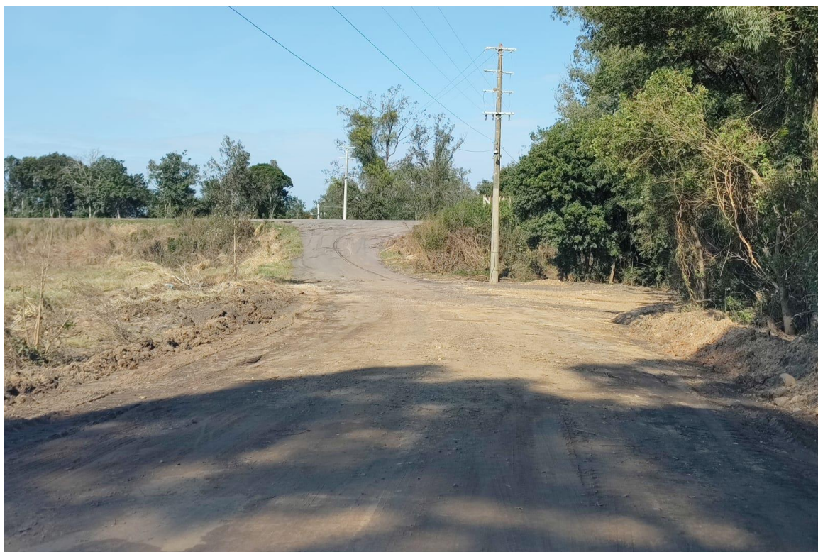
Figura 5 - Km 407,200 – Acesso a Balsa – Estrada de acesso a Praia Nova
