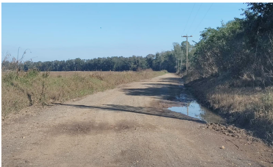
Figura 6 - Km 407,200 – Acesso a Balsa – Estrada de acesso a Praia Nova
