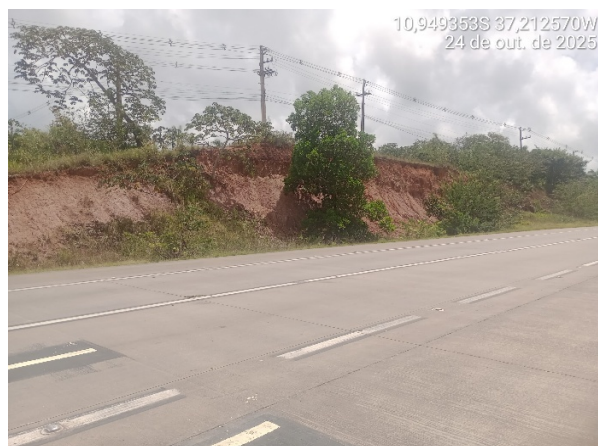
Trecho 1 no km 101,6, (160 m) LD – São Cristóvão
