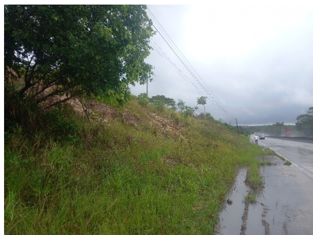
Trecho 3 no km 110,3 (125 m) LD – São Cristóvão
