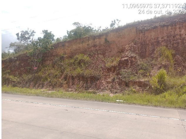
Trecho 11 no km 131,3 (100 m) LE – Estância
