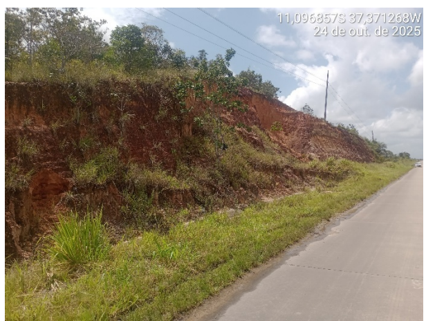
Trecho 10 no km 129,5 (110 m) LE – Estância
