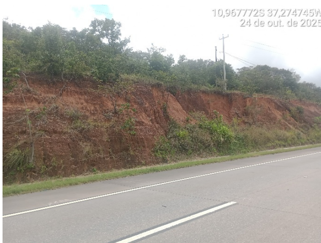
Trecho 2 no km 108,9, (180 m) LD – São Cristóvão
