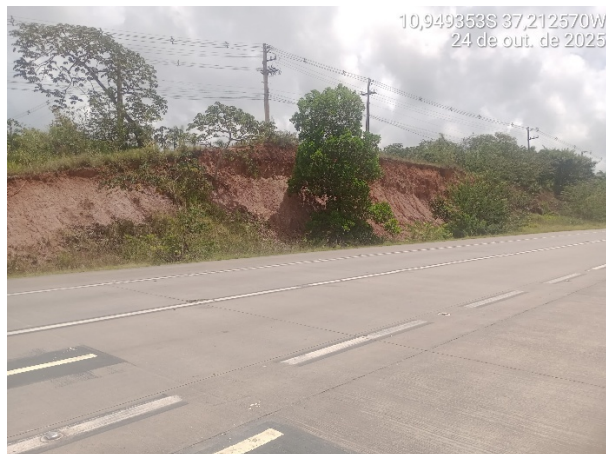
Trecho 1 no km 101,6, (160 m) LD – São Cristóvão
