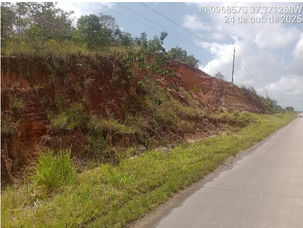
Trecho 10 no km 129,5 (110 m) LE – Estância
