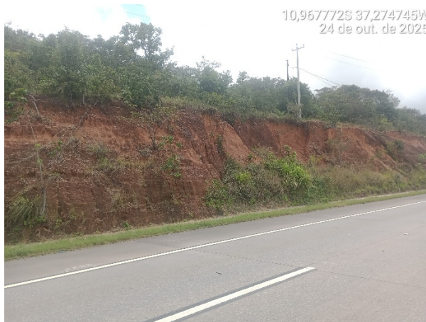
Trecho 2 no km 108,9, (180 m) LD – São Cristóvão
