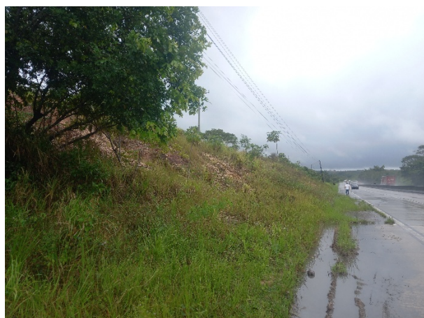
Trecho 3 no km 110,3 (125 m) LD – São Cristóvão
