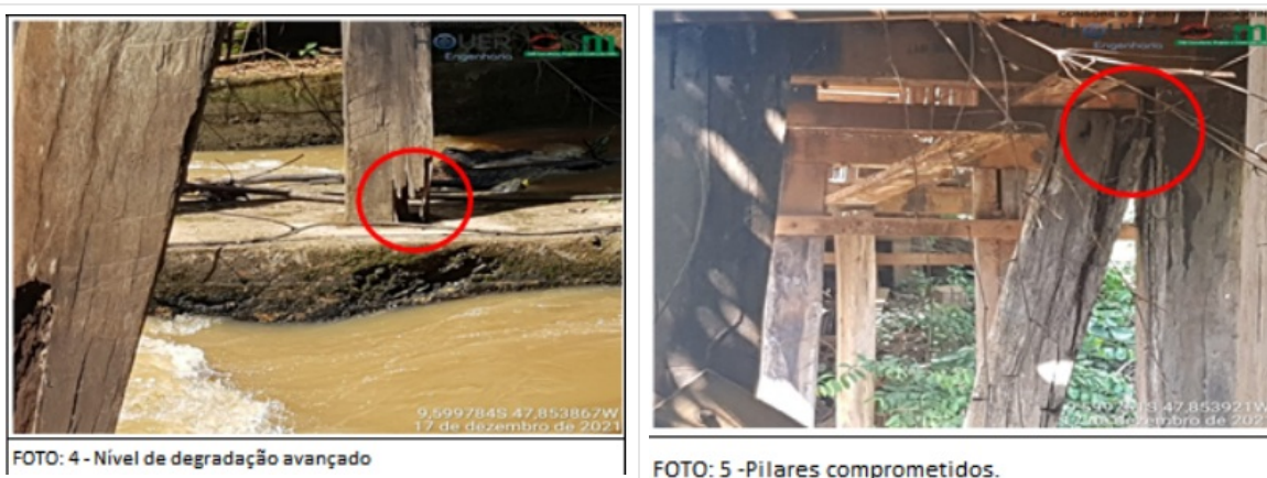
Figura 01 – Registros fotográficos do levantamento de ocorrência (17-12-2021) sobre a ponte do Córrego Areia (SEI nº 10374730).
