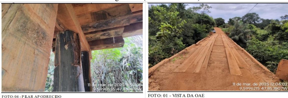
Figura 02 – Registros fotográficos do levantamento de ocorrência (11-03-2025) sobre a ponte do Córrego Areia.
