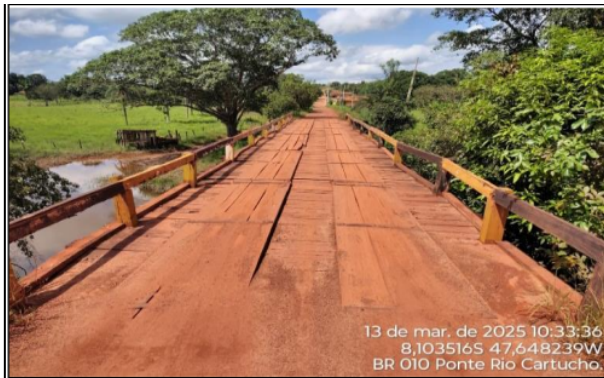
FOTO: 01 - VISTA DA OAE
