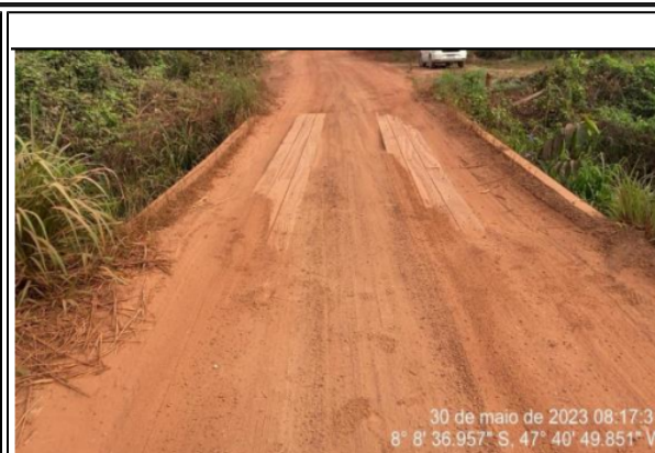
FOTO: 02 - VISTA DA OAE
