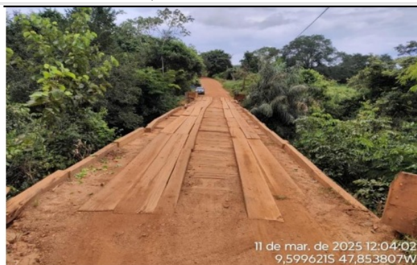
FOTO: 01 - VISTA DA OAE
