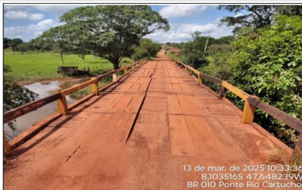
FOTO: 01 - VISTA DA OAE
