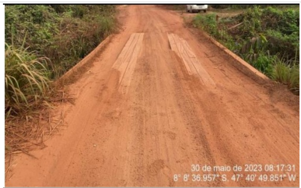
FOTO: 02 - VISTA DA OAE
