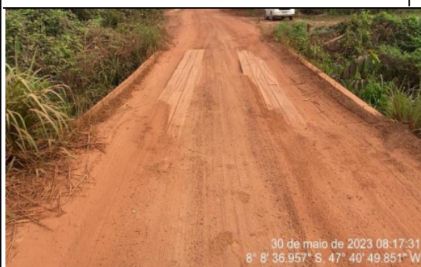
FOTO: 02 - VISTA DA OAE
