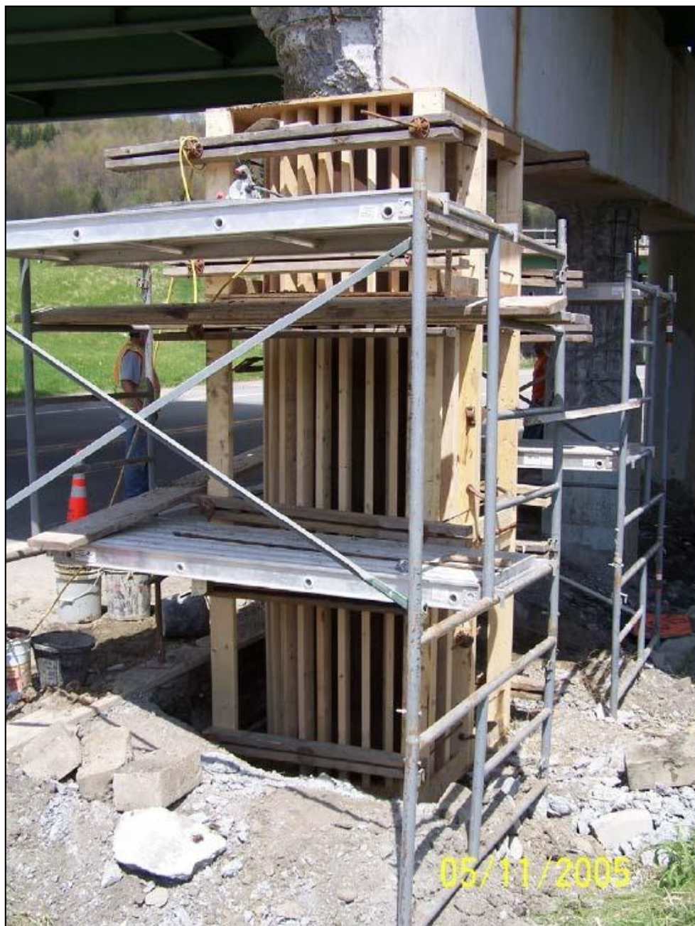
Fig. 5.1 – Plataformas apoiadas no solo (NYSDOT, 2008)
