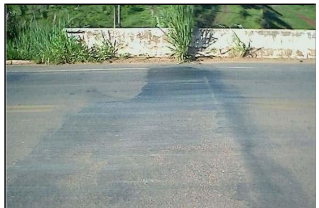
Figura 3.2 - Sujeira e vegetação junto à barreira
