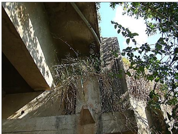
Fig. 3.3 – Vegetação na junta do encontro
