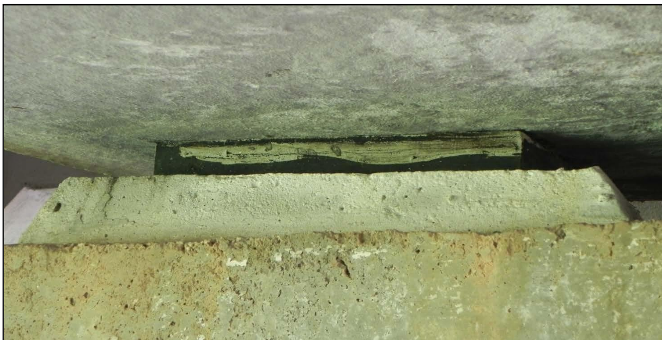
Fig. 3.2 - Aparelho de apoio metálico
