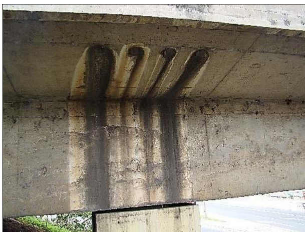
Fig. 3.1 – Drenos inadequados
