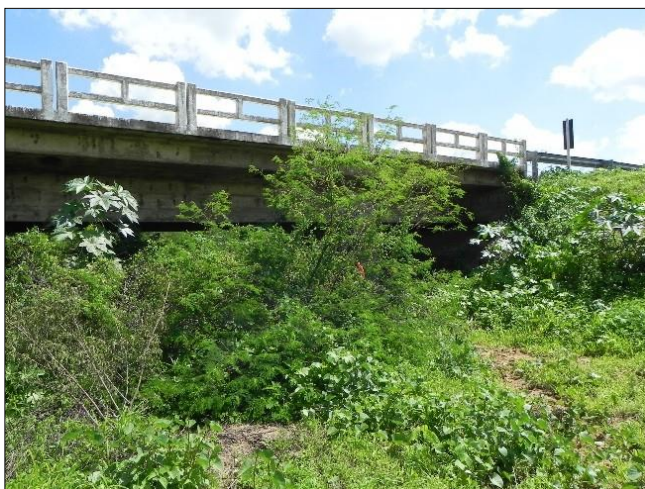
Fig. 3.1 – Arbustos sob a ponte
