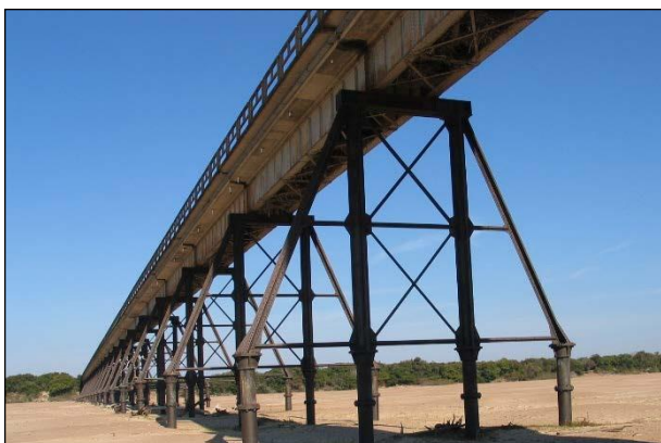
Figura 3.3 – Material acumulado na estrutura
