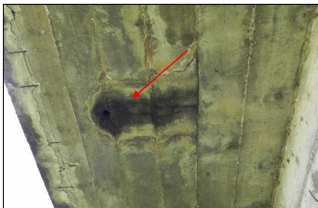
Fig. 3.1 – Dreno obstruído
