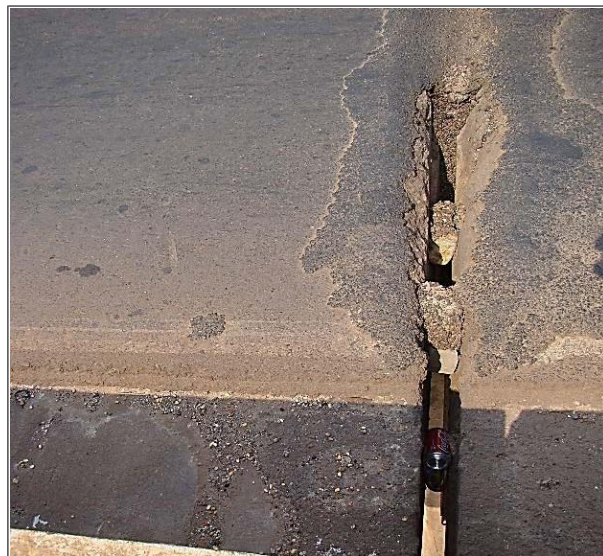
Fig. 3.2 – Junta obstruída
