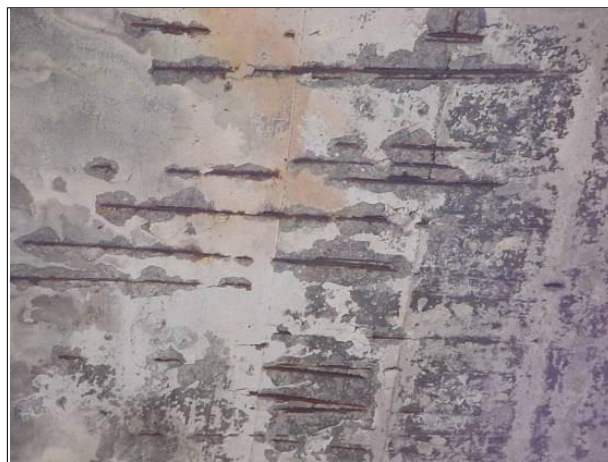
Figura 3.6 – Cobrimento deficiente
