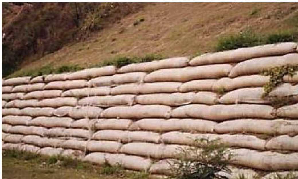
Fig. 4.1 – Contenção com solo-cimento ensacado (SICRO, 2017).
