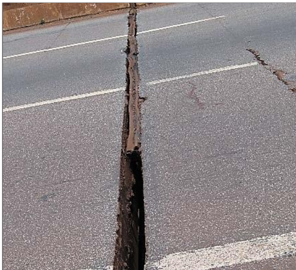
Fig. 3.1 – Elastômero danificado
