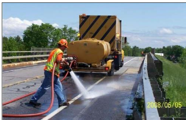
Fig. 5.2 – Jateamento d'água sob pressão*
