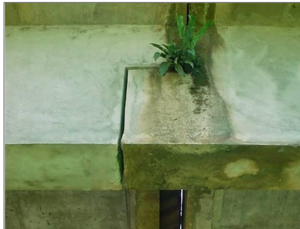
Fig. 3.2 – Crescimento de vegetação na junta
