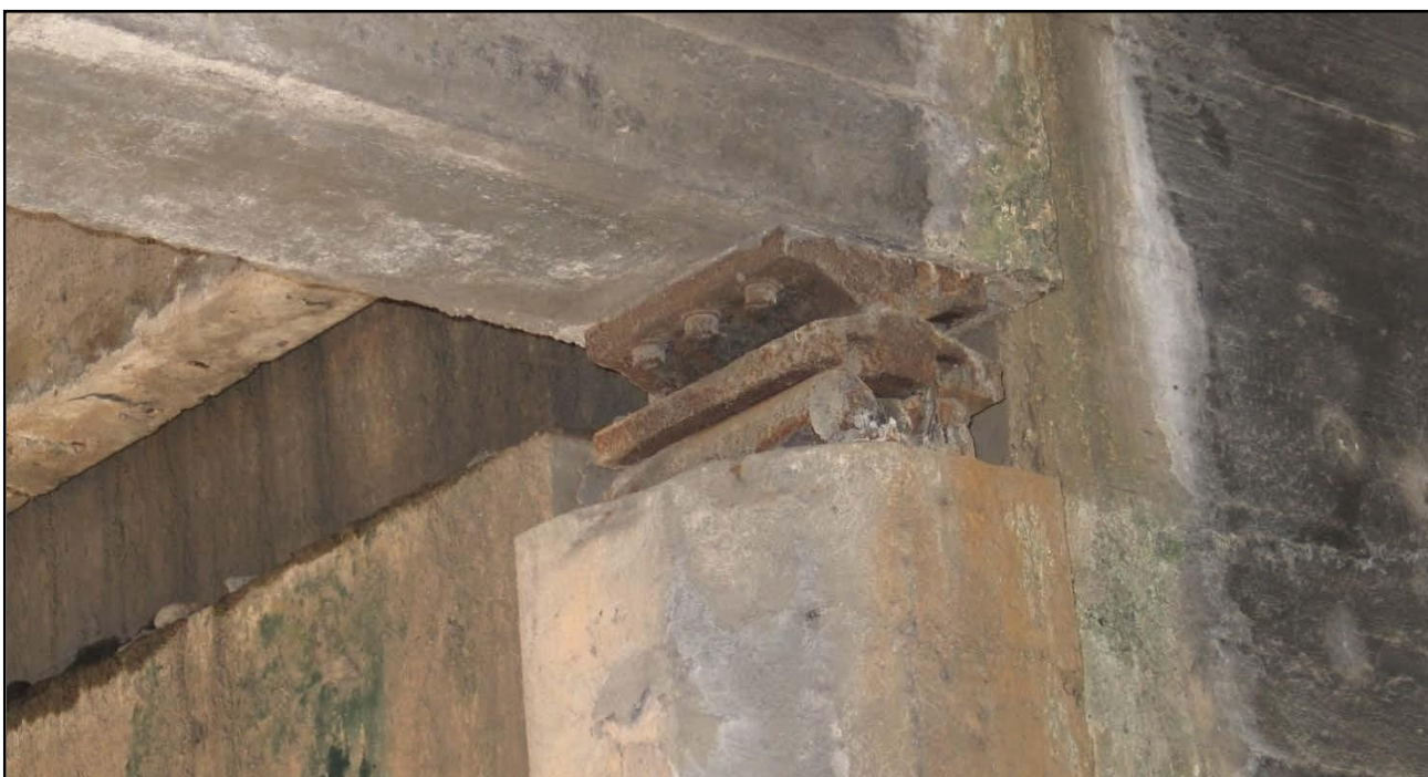
Fig. 3.2 - Aparelho de apoio metálico
