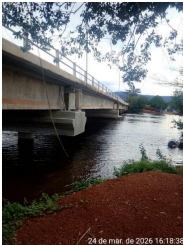
FOTO 4 – RECUPERAÇÃO DOS ELEMENTOS DA OAE.
