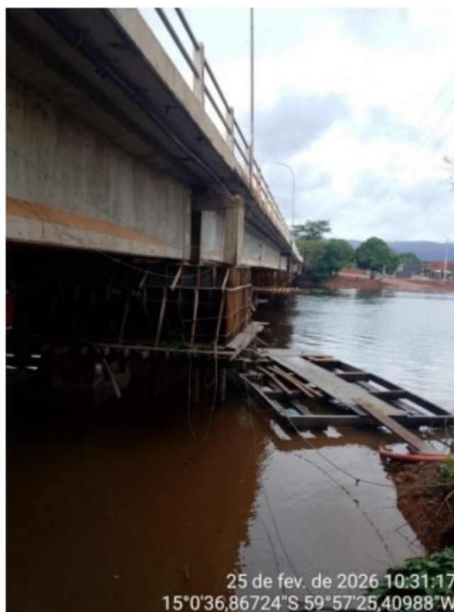
FOTO 3 – RECUPERAÇÃO DOS ELEMENTOS DA OAE.
