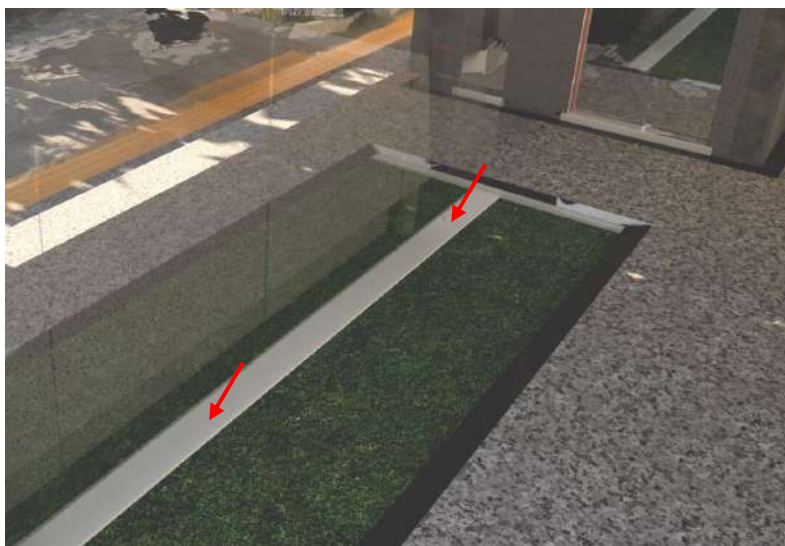
Indicação do local da confecção da soleira em concreto
