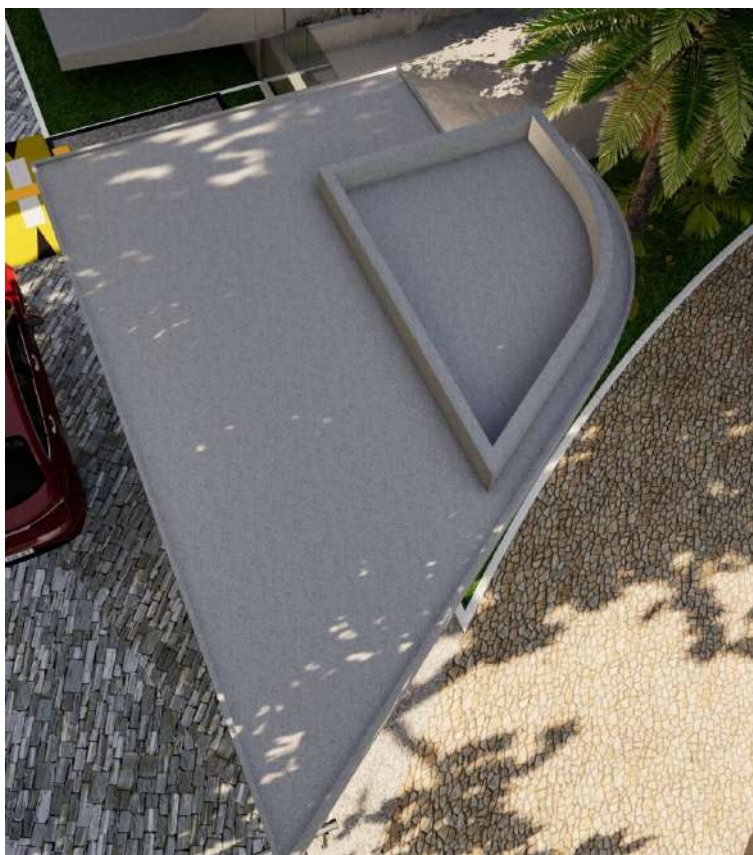
Laje a ser impermeabilizada
