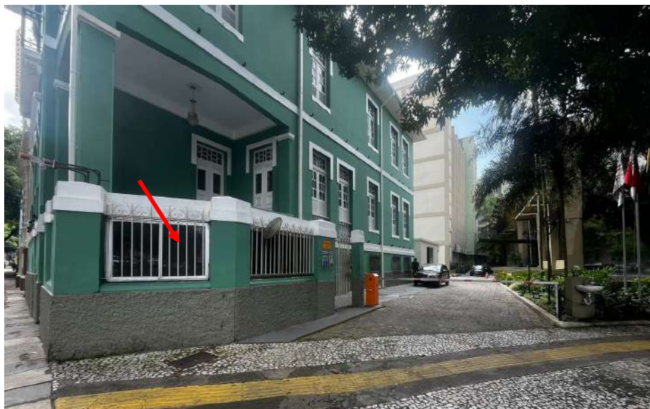
Guarita atual a demolir, permanecendo o muro existente.
