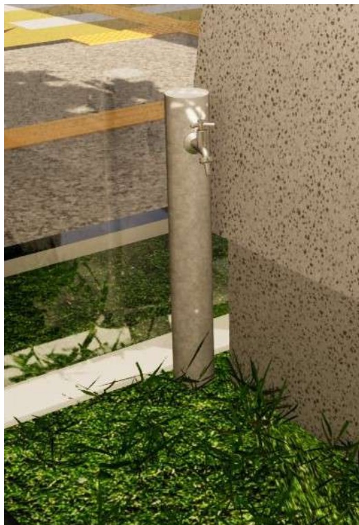
Pilarete em concreto com torneira a ser confeccionado.
