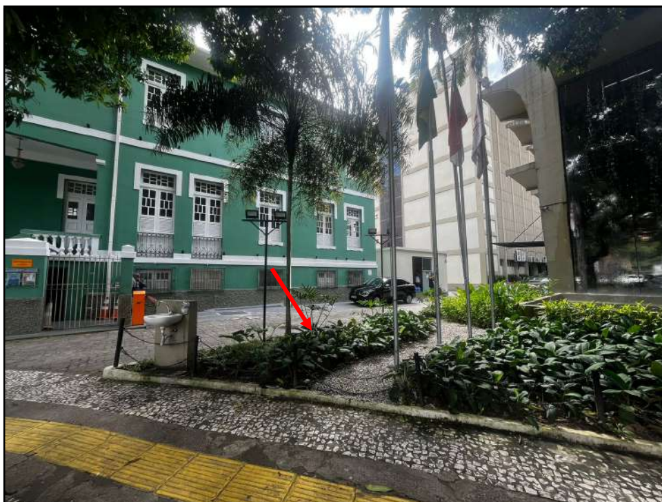
Indicação do local da construção da nova guarita
