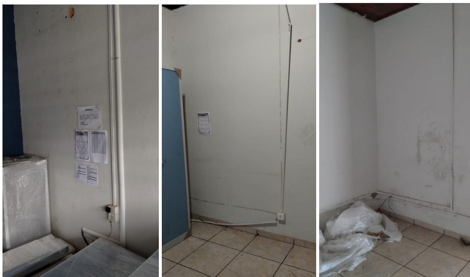
Imagens 24 a 26: Todos os pontos de tomada da edificação estão aparentes por canaletas
