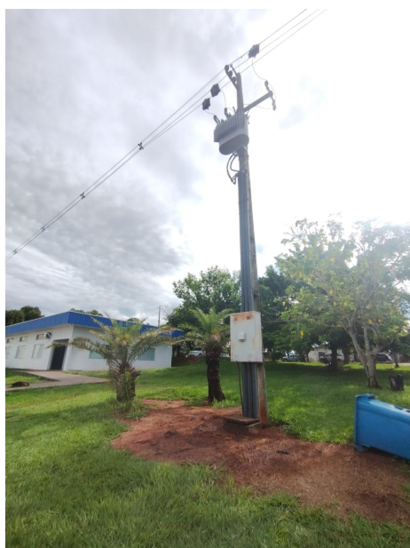
Imagens 01 e 02: Transformador que já apresentou problema de derramamento de óleo diesel
