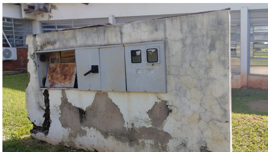
Imagem 23: desativação do quadro
