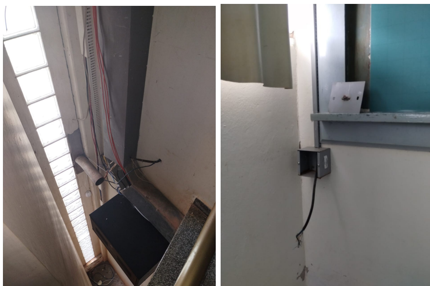
Imagens 21 e 22: Fios desencapados do bloco didático e CAC
