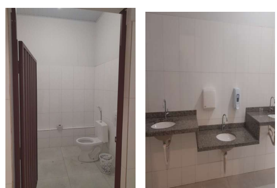
VISTA INTERNA DO BANHEIRO
