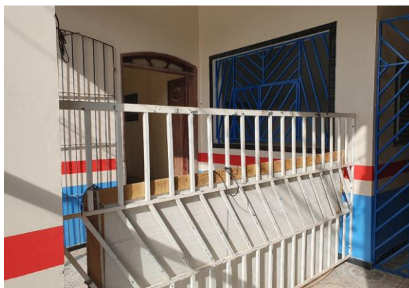
VISTA DA ENTRADA
