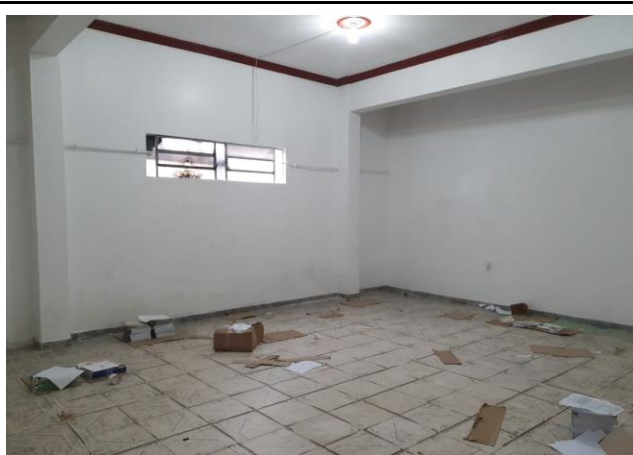
VISTA DA SALA
