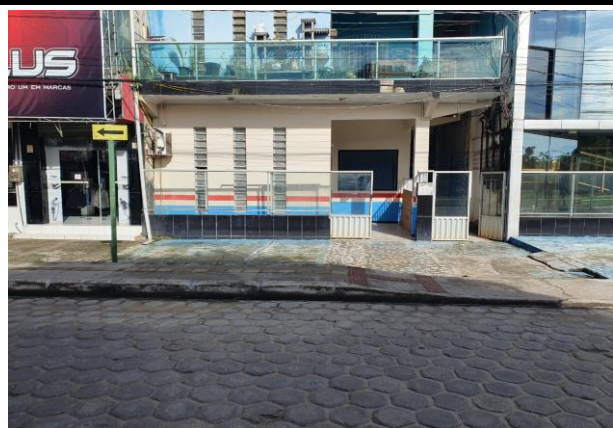
VISTA DA FACHADA (TÉRREO)
