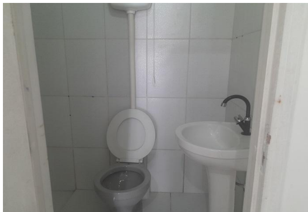
VISTA INTERNA - BANHEIRO
