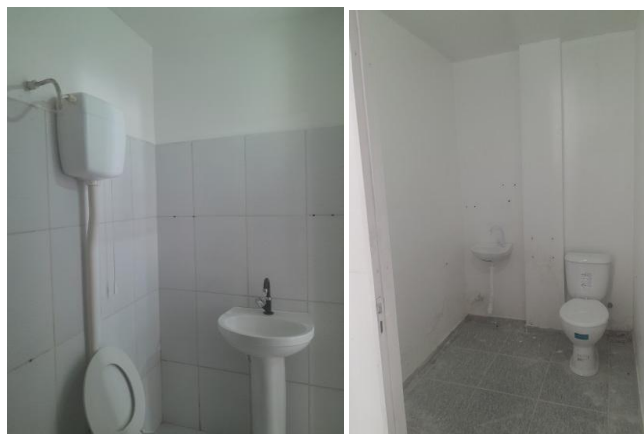
VISTA INTERNA BANHEIRO
