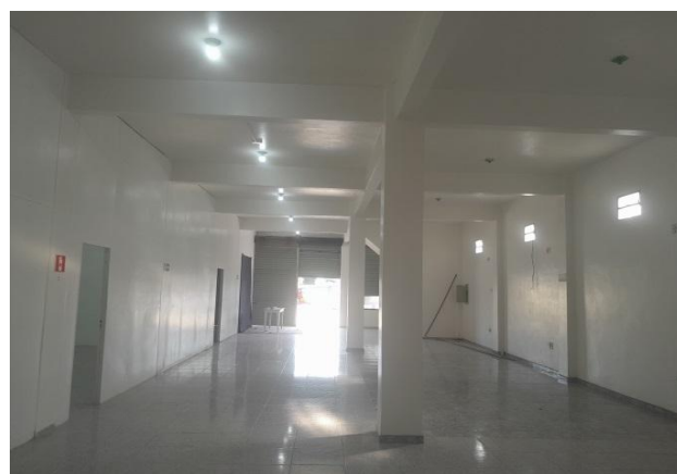
VISTA INTERNA - GERAL
