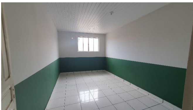
VISTA DA SALA DE AULA 09
