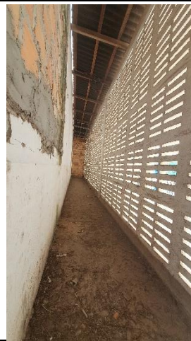
VISTA DA ÁREA TÉCNICA
