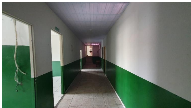
VISTA DA CIRCULAÇÃO DO PAV. SUPERIOR
