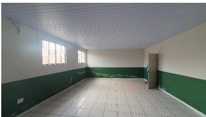
VISTA DA SALA DE AULA 10
