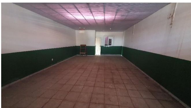
VISTA DA SALA DE AULA 07
