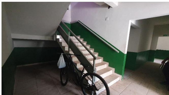
VISTA DA ESCADA DE ACESSO AO PAV. SUPERIOR
