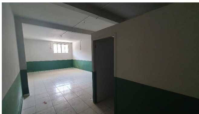
VISTA DA SALA DE AULA 04
