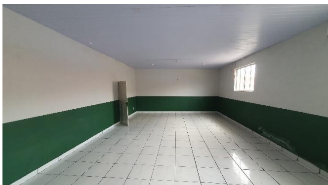
VISTA DA SALA DE AULA 08
