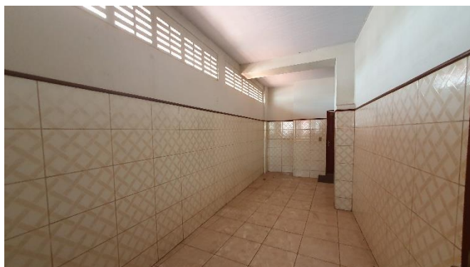
VISTA DA SALA DE AULA 06
