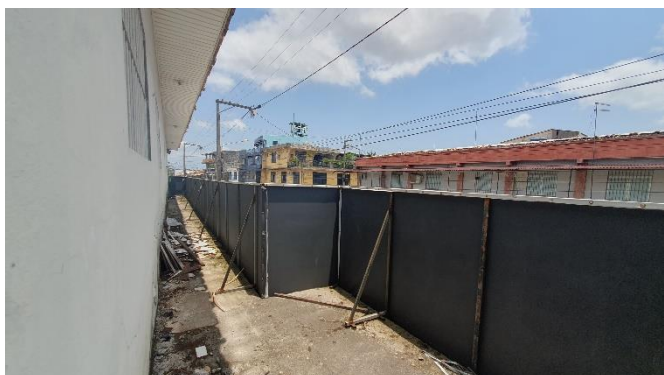
VISTA DA MARQUISE / ÁREA TÉCNICA
