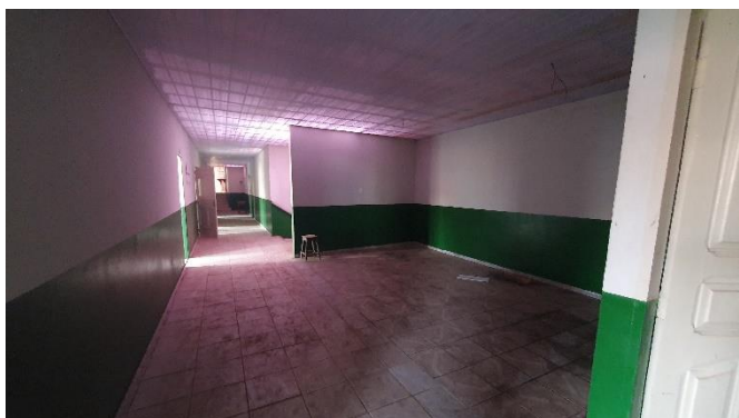
VISTA DA CIRCULAÇÃO DO PAV. SUPERIOR
