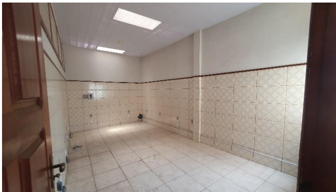
VISTA DA SALA DE AULA 05
