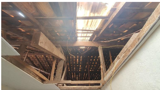
VISTA DO TELHADO SOB O FORRO
