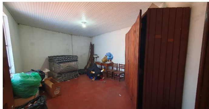
Vista da Sala do 2 Pavimento
