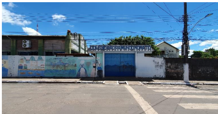
Vista da Fachada do Imóvel pela Rua 24 de Outubro
