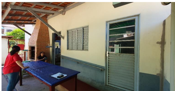
Vista da Área Externa da Cozinha
