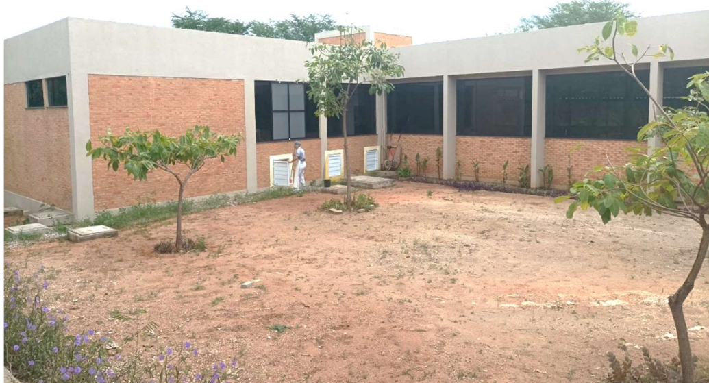
Foto 3- Vista da fachada do prédio do RU. Pórtico. Campus da UFCG/CDSA. Fonte: O AUTOR.
