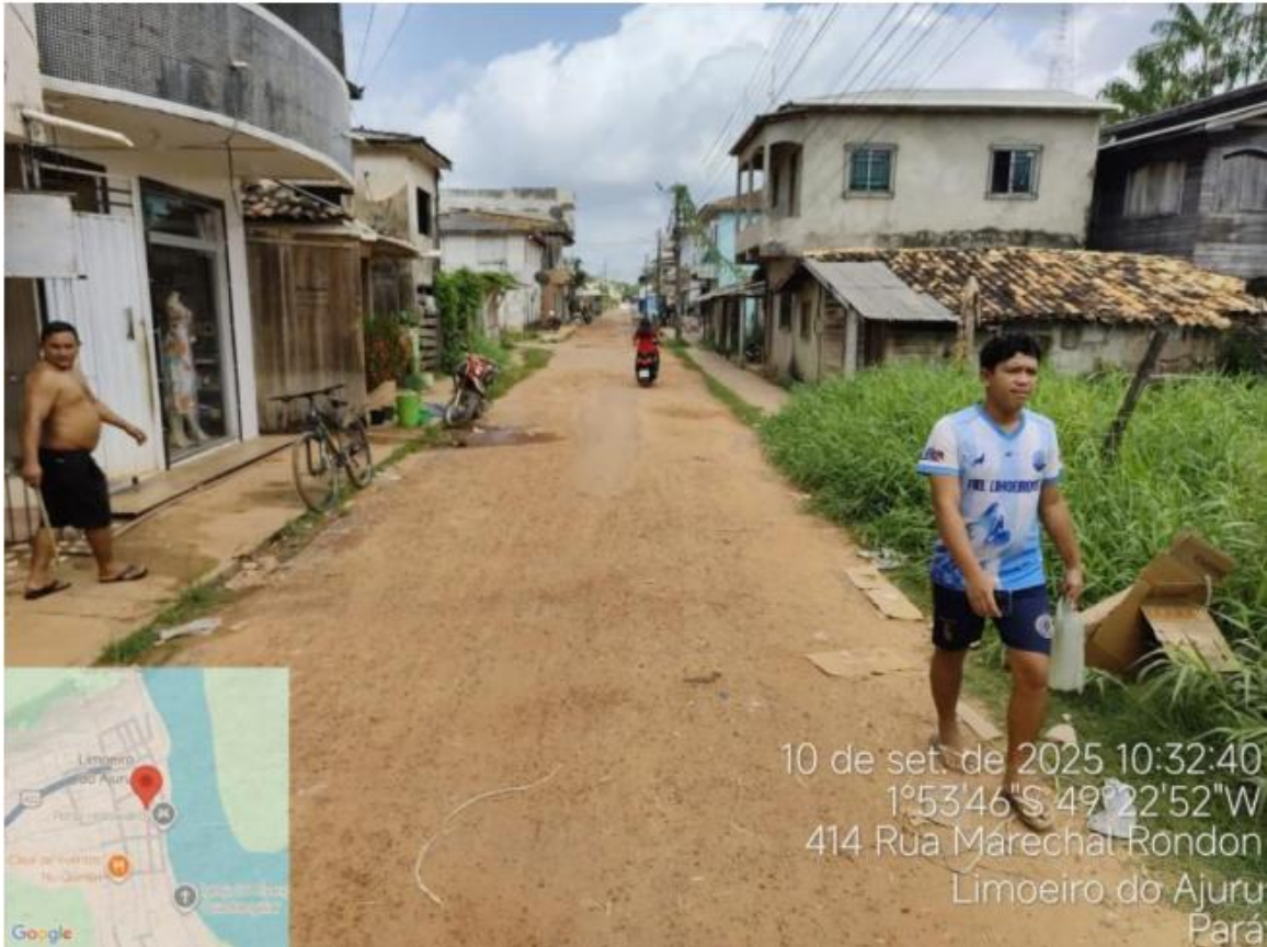
FOTO 05: TV. ONEZINHO RODRIGUES , trecho onde percebe-se a ausência de asfaltamento.
