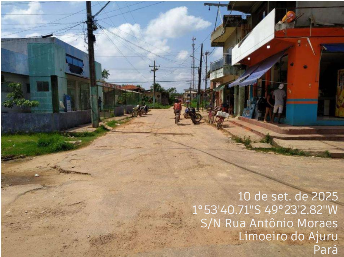
FOTO 19: RUA ANTÔNIO MORAES (Trecho Próximo à UBS Cuba).
