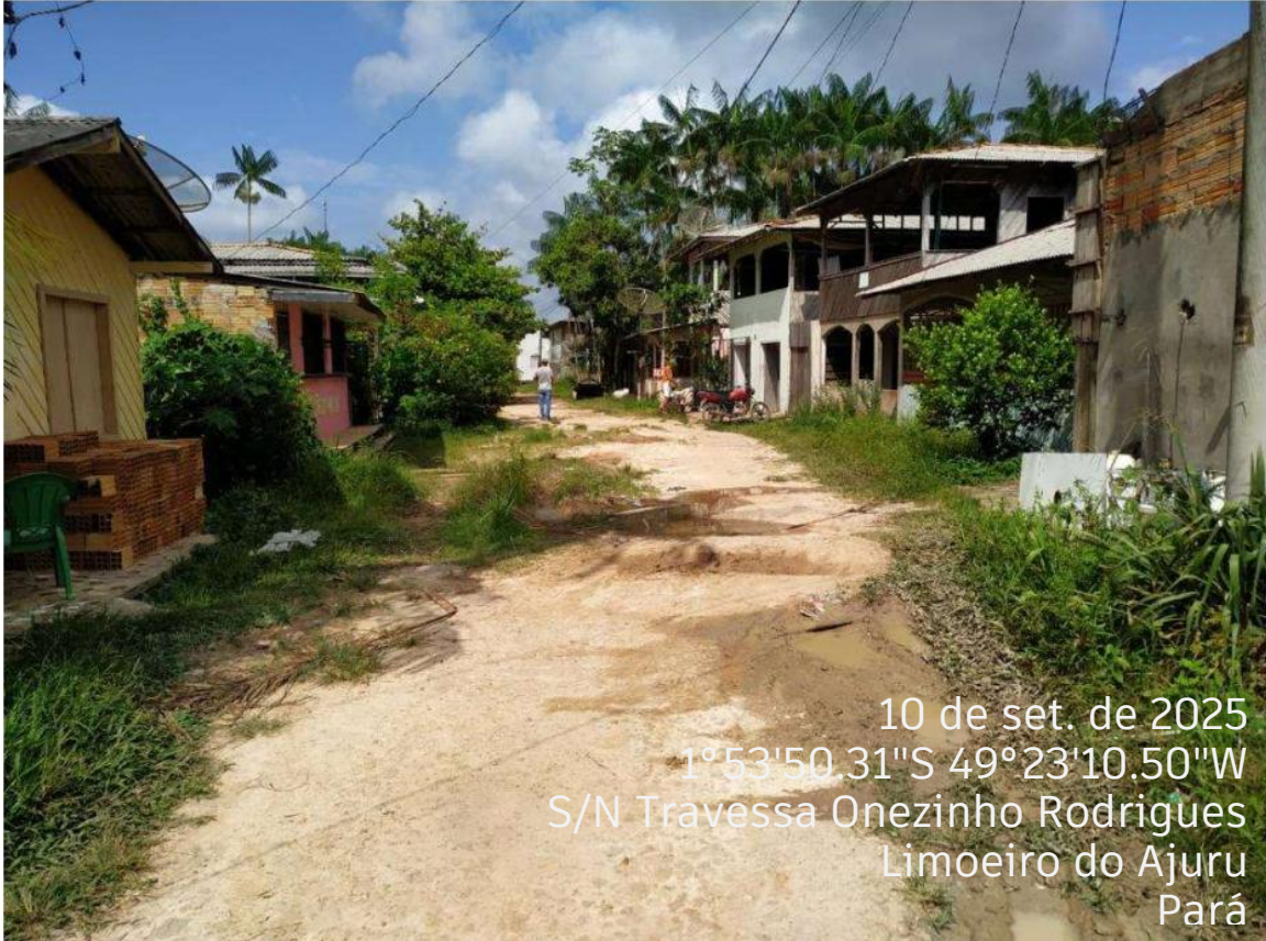
FOTO 01: TV. ONEZINHO RODRIGUES (Trecho entre a rua nova e rua nova IV). Pode-se perceber a irregularidade da via, inexistência de calçada, presença de lama, existência de vegetação ao longo da travessa e pontos de alagamento.
