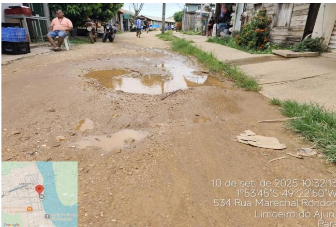
FOTO 08: RUA MARECHAL RONDON , trecho onde nota-se a ausência de asfaltamento, presença de lama e pontos de alagamento.
