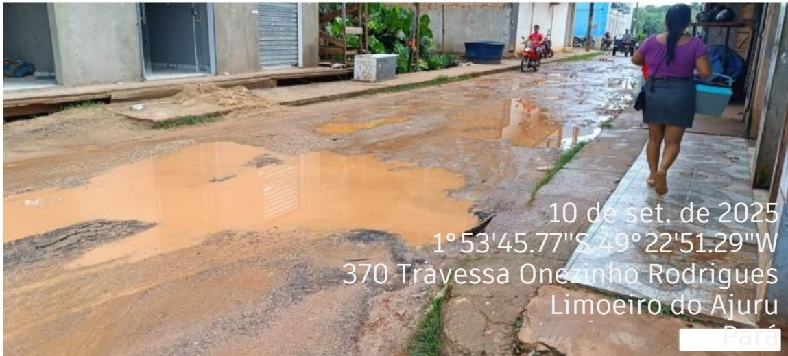
FOTO 03: TV. ONEZINHO RODRIGUES , trecho onde nota-se a irregularidade da via, presenca de lama e pontos de alagamento.
