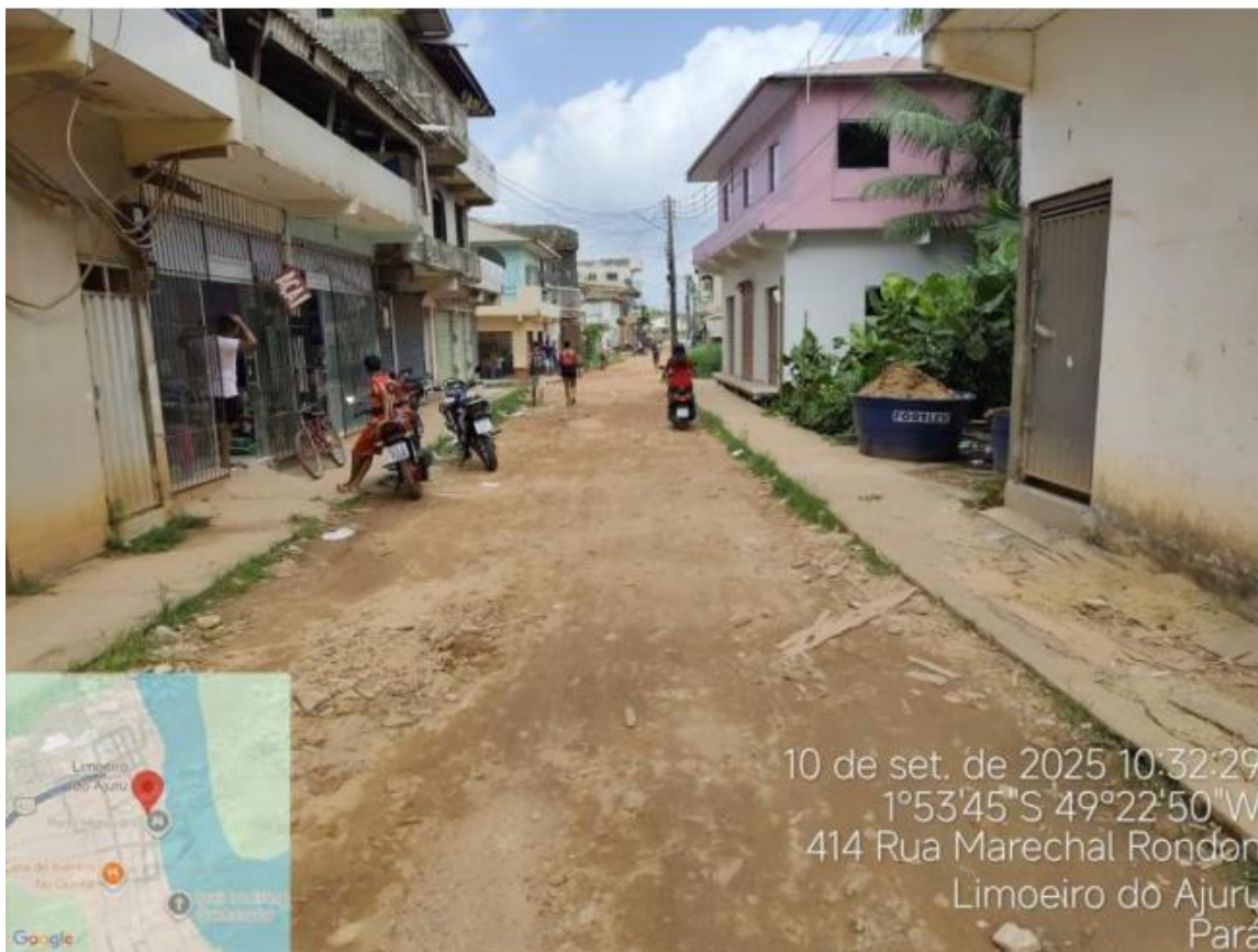
FOTO 06: TV. ONEZINHO RODRIGUES , trecho onde nota-se a ausência de asfaltamento.
